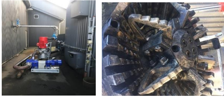
Figur 24: Disruptor fra Vogelsang (venstre) og skæreenhed (højre).
