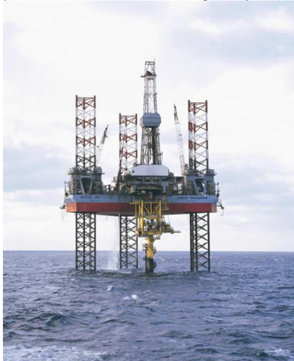
Fig. D-1 Typisk jack-up borerig (Maersk Endeavour), her placeret ved platformen Kraka STAR
