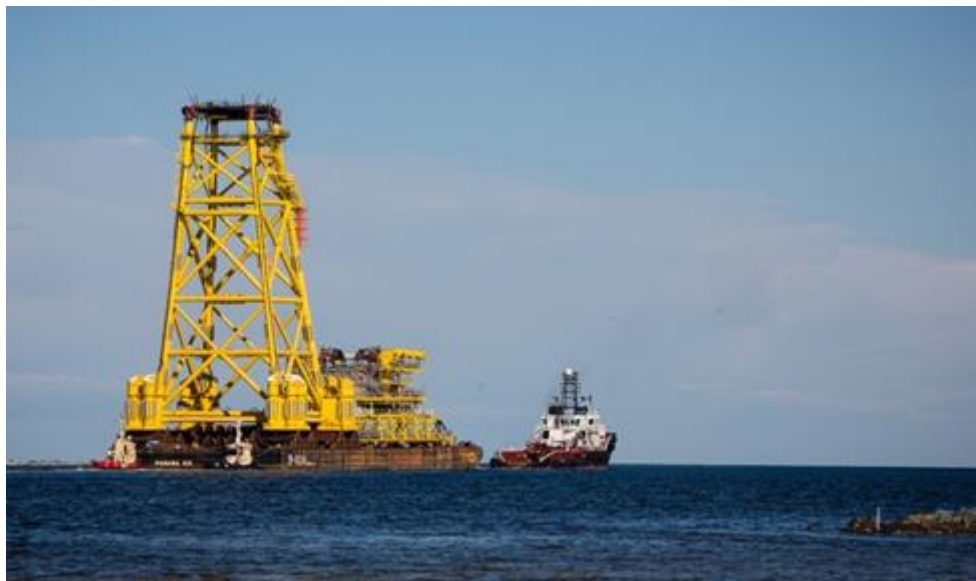
Fig. B-4 Tyra Sydøst-B anlæg (jacket-konstruktion, overbygning og bro) – bugseret til borested i 2014
