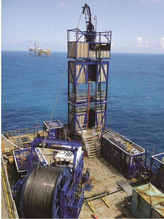
Fig. D-5 Brøndintervention ved Halfdan, 2012
