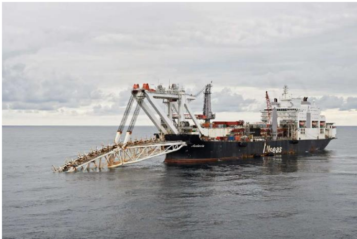
Fig. B-1 Læggefartøj under operation
