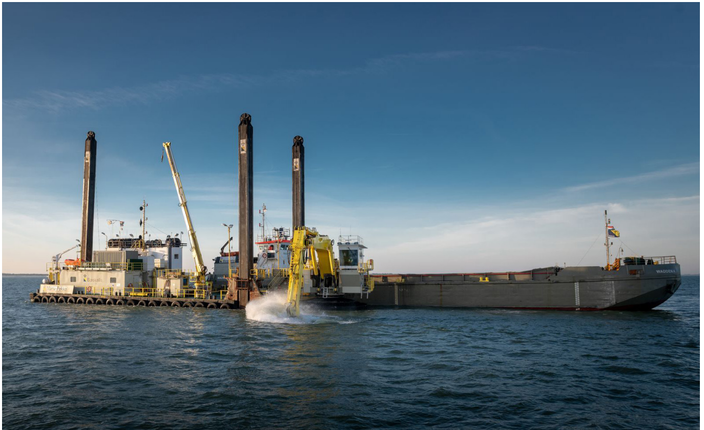
Gravemaskine monteret på pram til nedgravning af rørledning på lavt vand (10-12 m)
