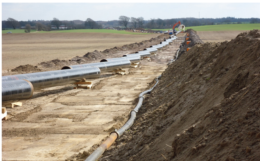
Rør udlagt i det ryddede arbejdsbælte
