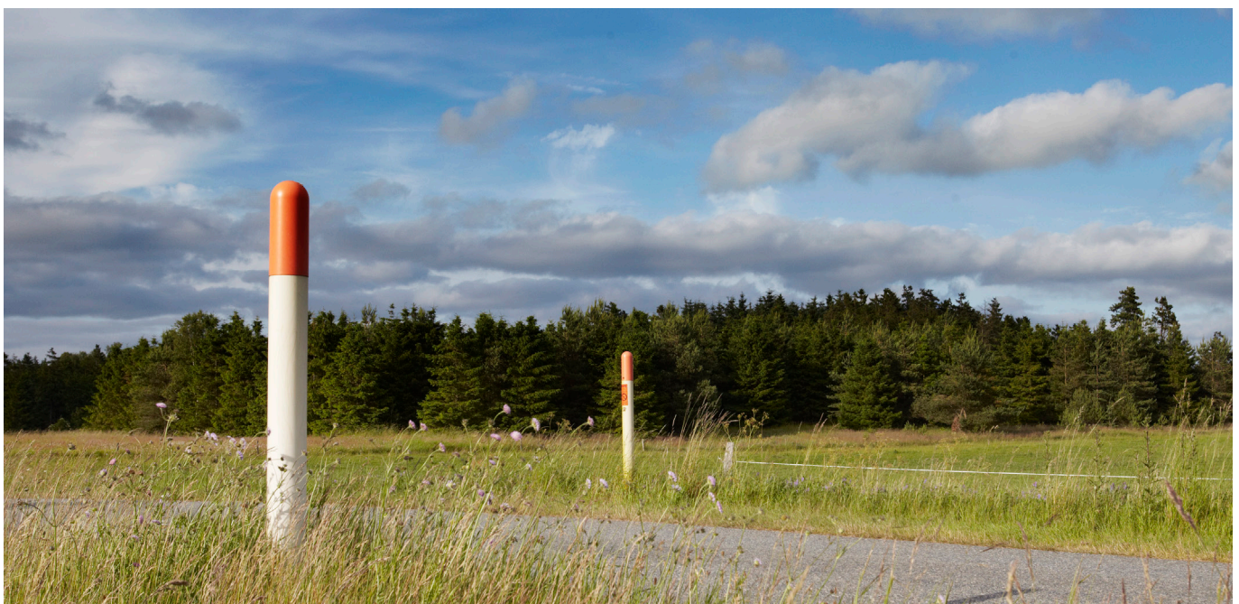
Når anlægsarbejdet er færdigt, er det kun markeringspæle, der viser, hvor gasrørledningen er placeret.
