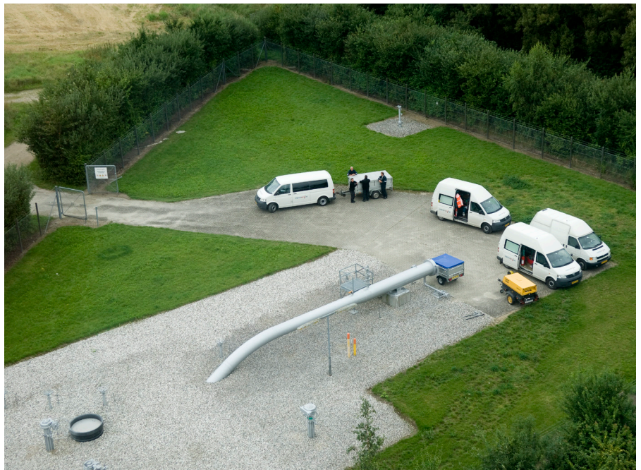
Eksempel på den overjordiske del af en linjeventilstation. Der etableres 17 stationer langs strækningen henover Danmark.
