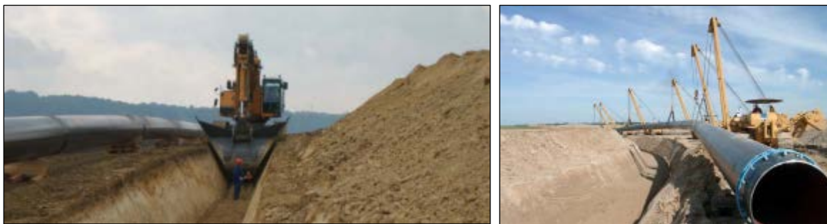
Figur 6-21 Udgravning for rørledning på land (til venstre) og nedsenkning af rørledning i renden.
