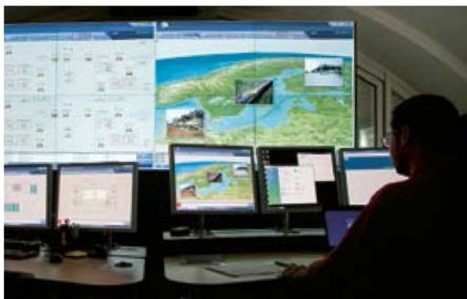
Figur 0-7 Nord Stream-kontrolcentret står for den daglige drift af den nuværende Nord Stream-rørledning.
