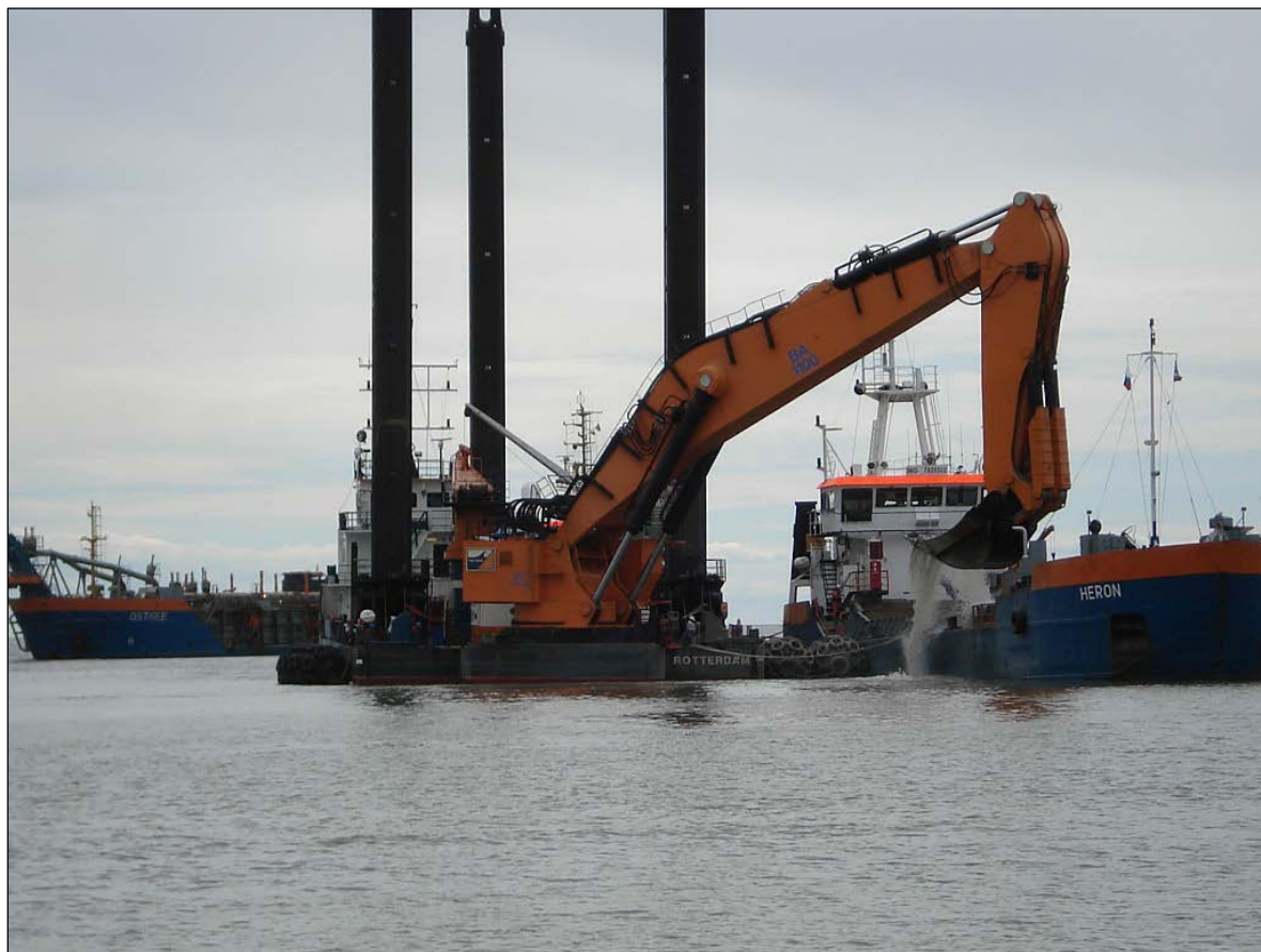
Figur 6-16 Rendegraver med splittepram forøjet ved siden (til højre).
