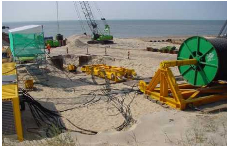
Figur 4.16: Eksempel på trækspil til ilandføring af en rørledning.
