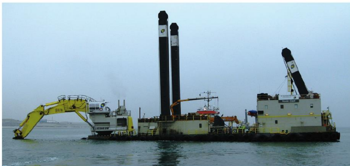
Figur 3-14 Typisk gravemaskine til nedgravning på lavt vand.
