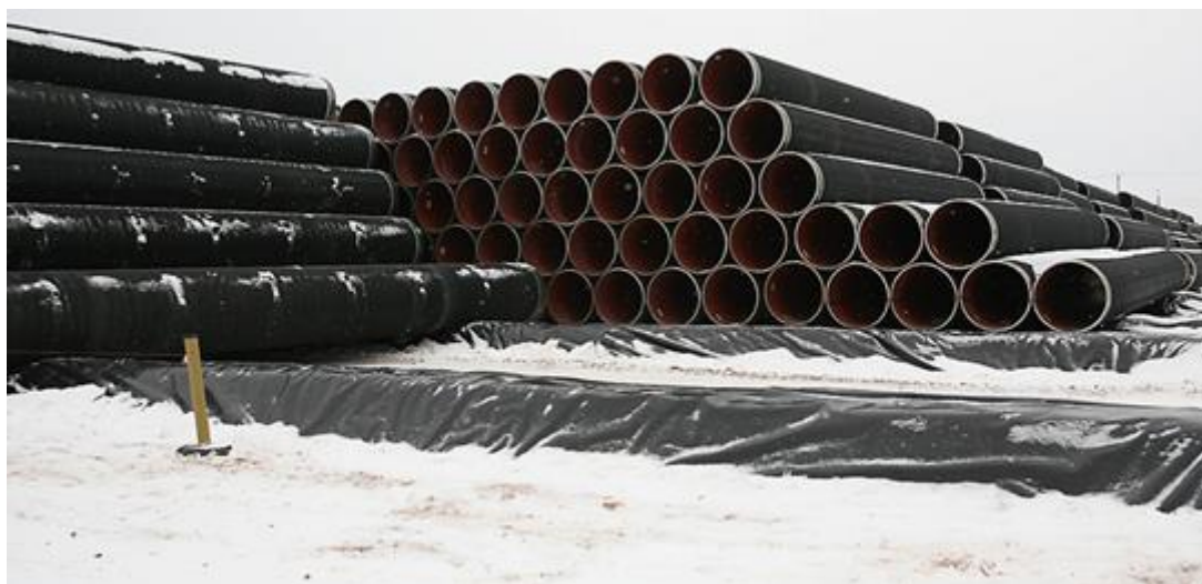
Figur 3-23 Eksempel på opbevaring af vægtbelagte rørsamlinger i en havn (Rambøll, 2018b).
