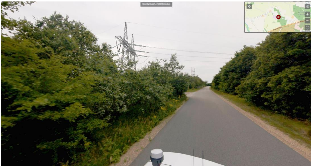
Figur 7-22 Højspændingsledninger- og master ved Station Idomlund set fra Idomlundvej. Transformatorstationen ligger til venstre for vejen. Blikket er rettet mod nordvest. Kilde: COWI Gadefoto.
