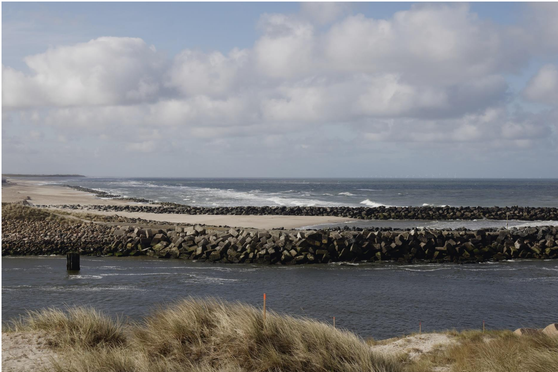
Fotostandpunkt 1 – Thorsminde ved Strandingsmuseum St. George – Fotoretning venstre – Scenarie 2 – Kumulative forhold – Dag – Maksimal sigtbarhed – 111 havvindmøller – 27 MW – Totalhøjde 330 m – Samlet 3 GW – Basis – 4/6
