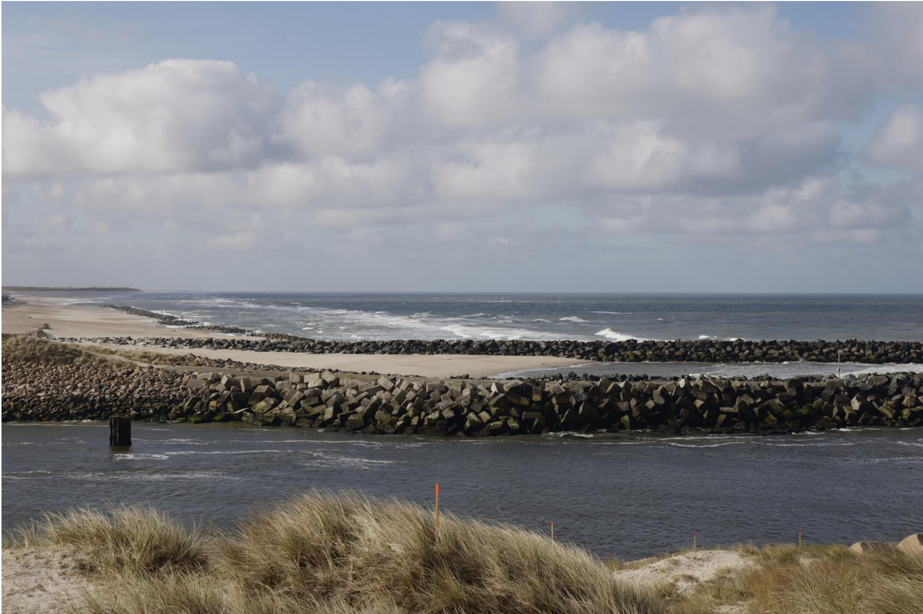
Fotostandpunkt 1 – Thorsminde ved Strandingsmuseum St. George – Fotoretning venstre – Eksisterende forhold – Dag – Maksimal sigtbarhed – 1/6
