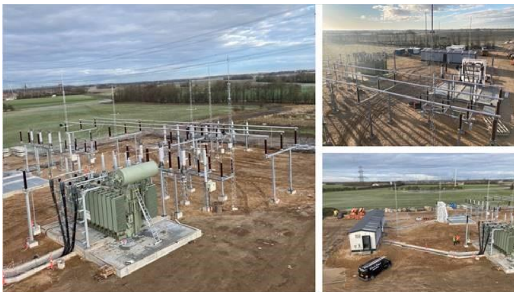
Figur 2.4 Eksempel på delvis åben transformerstation
