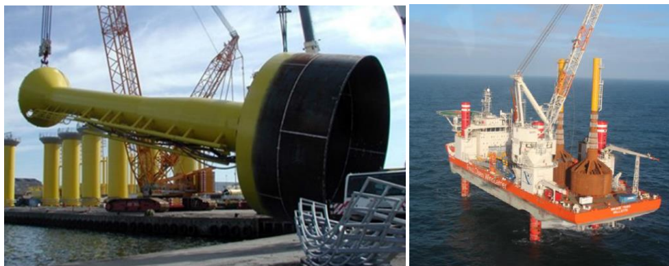
Figur 5.4.5 Sugebøttefundament på land (venstre) samt ombord på installationsskib (højre). Billederne er fra etableringen af en vejrstation i tilknytning til Horns Rev II Havmøllepark. (Kilde: Universal Foundations)
