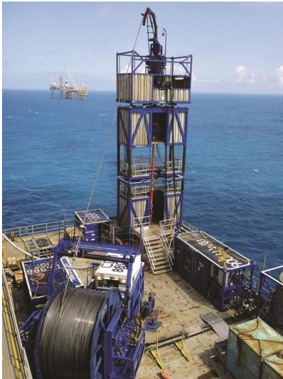
Fig. D-5 Brøndintervention ved Halfdan, 2012
