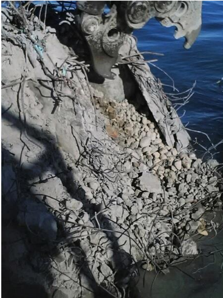
Figur 19 Sten fra et af kamrene på fundamentene, hvor sand var forventet.
