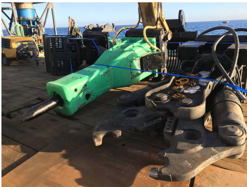
Figur 9 Hydraulisk hammer og saks til neddeling af betonfundamenter
