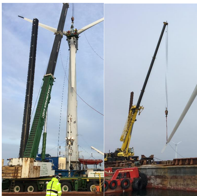
Figur 7 Hhv. hovedkran GMK 6300 og hjælpekran 4080 til løft af mølledele
