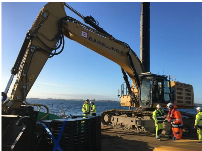
Figur 8 80 tons gravemaskine på dækket af jack-up pram
