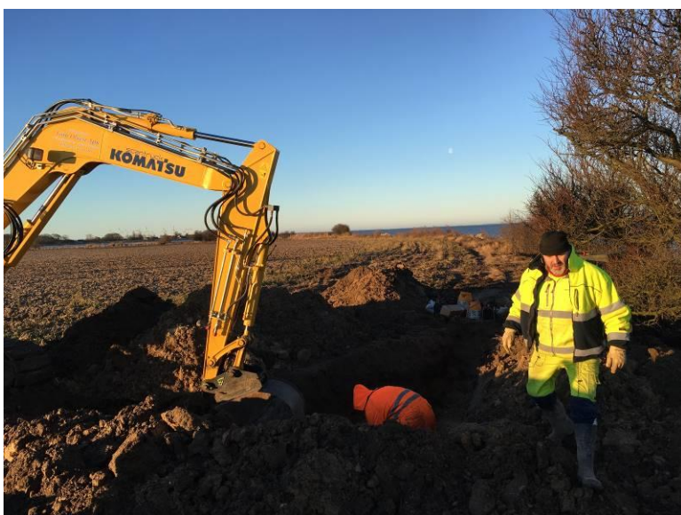
Figur 14 Opgravning af ilandføringskablet bag ved stranden
