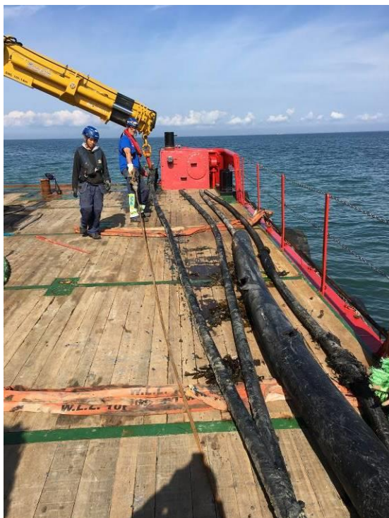
Figur 18 Kablet skæres i ca. 20 m stumper og lægges ud til siden inden næste sektion trækkes op på dæk
