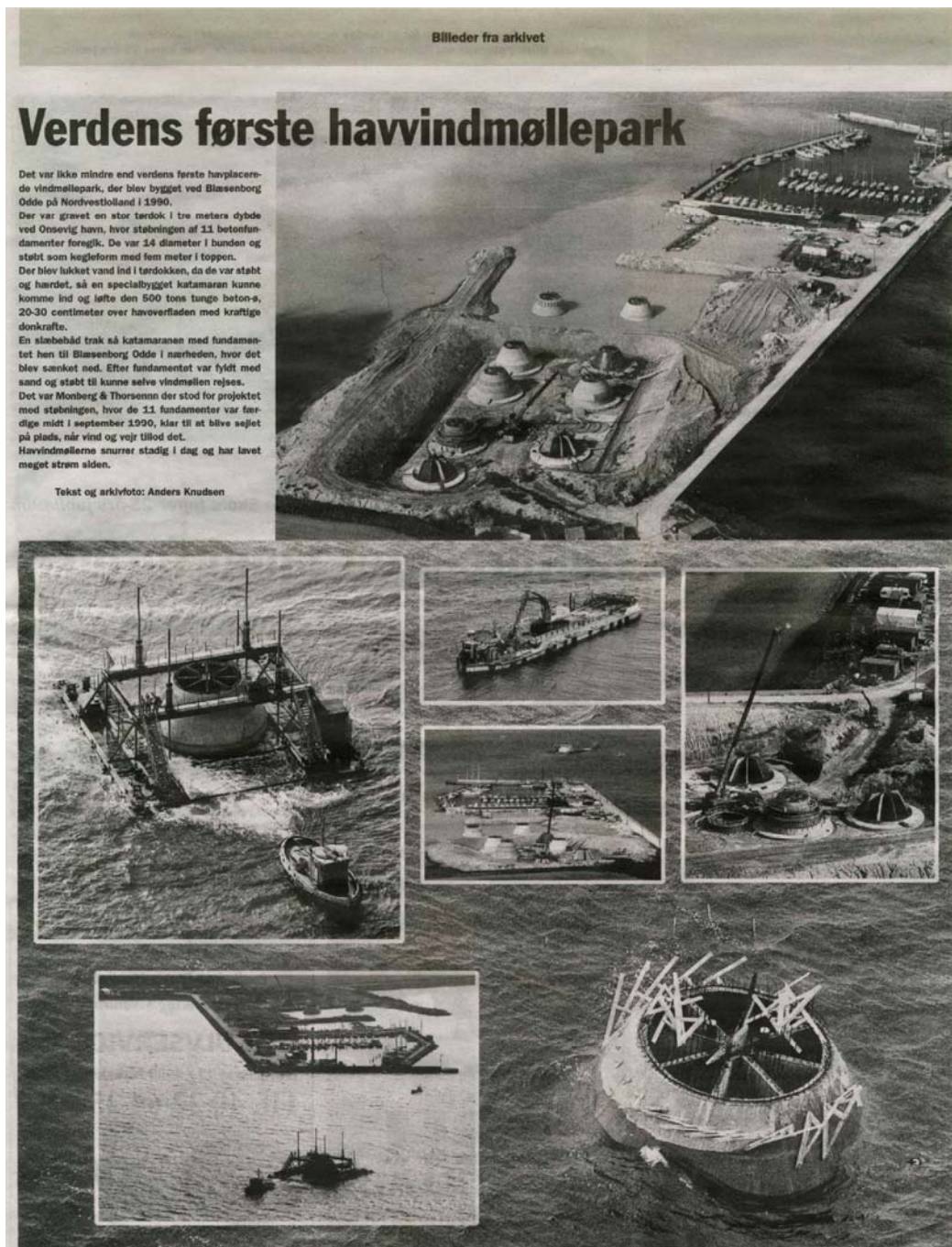
Figur 5: Arkiv fotos fra støbning og installation af fundamenter til Vindeby, 1990 (Kilde: Vestlollands Folketidende)
