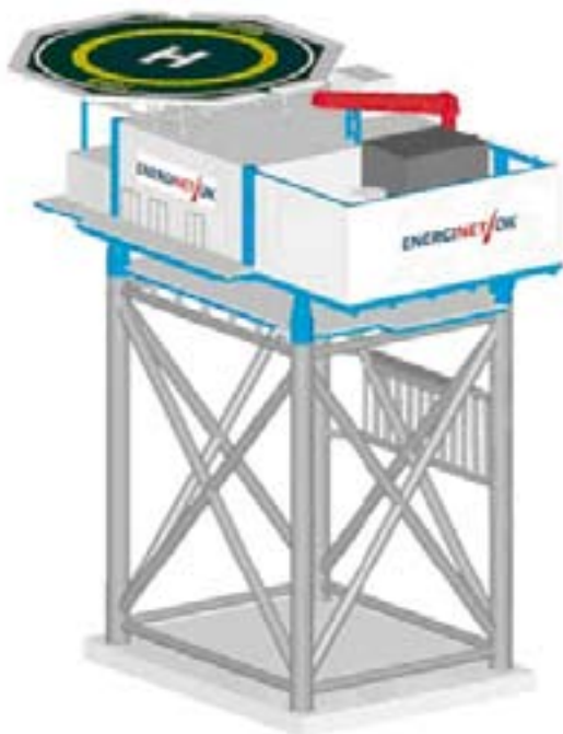
Figur 5.3.5 Transformerplatformen ved Horns Rev 2, der skal placeres på 13 meter vand godt 30 kilometer fra kysten. Helikopterdekkeet bliver placeret 36 meter over havet. Energinet.dk vælger leverandør i foråret 2007.
