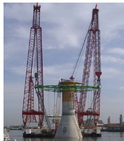
Figur 5-16 Nedramning af et monopælfundament, Burbo Banks Offshore Wind Farm (foto: MTHøjgaard)
