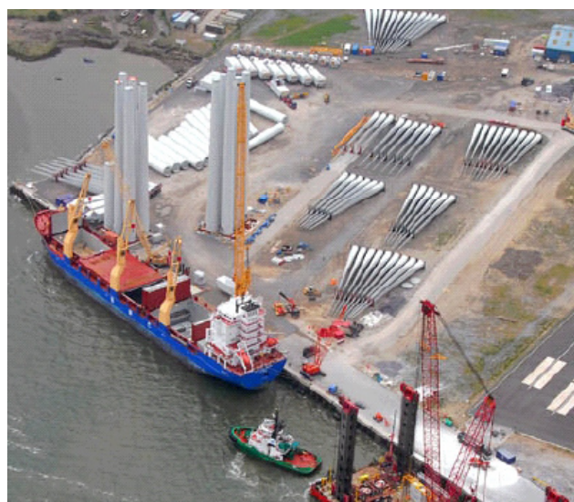
Figur 5-13 Opbevaring og transport af møllekompontener, Burbo Banks Offshore Wind Farm (foto: Siemens Energy) og installation af tårn og turbine, Lillegrund Offshore Wind Farm (foto: A2SEA).
