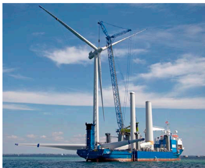
Figur 5-13 Opbevaring og transport af møllekompontener, Burbo Banks Offshore Wind Farm (foto: Siemens Energy) og installation af tårn og turbine, Lillegrund Offshore Wind Farm (foto: A2SEA).
