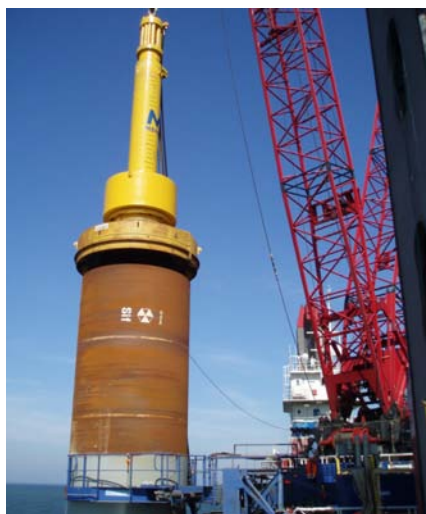
Figur 5-14 Nedramning af et monopælfundament, Burbo Banks Offshore Wind Farm (foto: MTHøjgaard)
