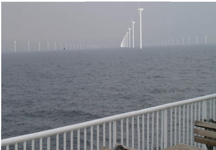
Figur 7-16 Anholt Havmøllepark set fra Grenaa-Anholt færgeren. Visualiseringen er baseret på en møllestørrelse på 2,3 MW opstillet i lineært opstillingsmønster
