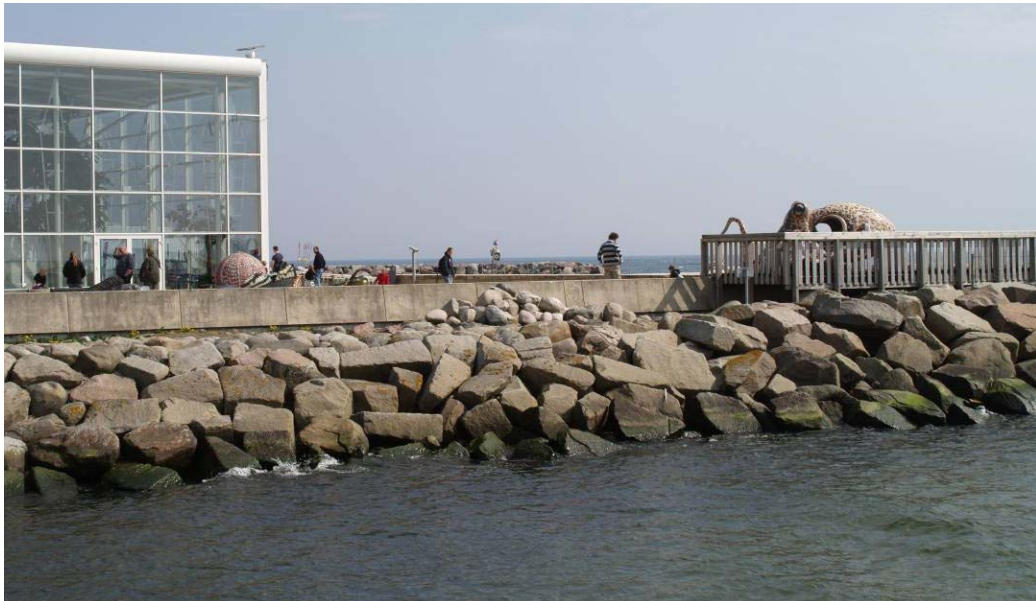
Figure 3-4 The Kattegat Center in Grenaa.
