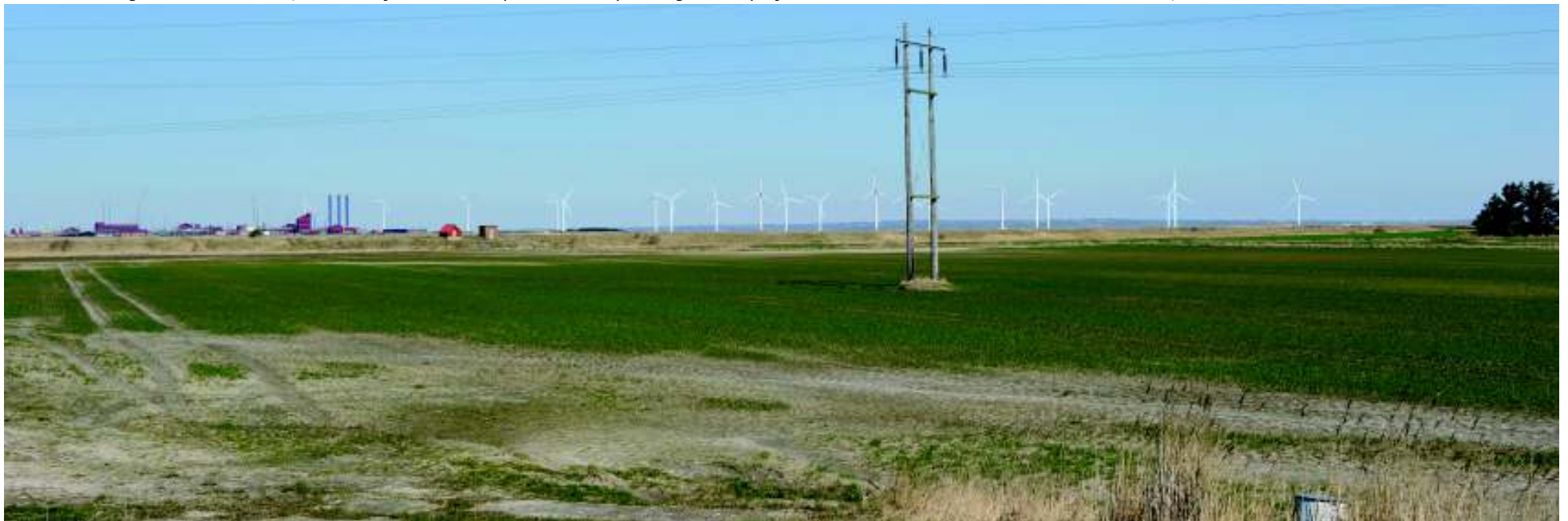
L3 Visualisering 7d med 12 stk 149,9 meter høje vindmøller opstillet i den sydvestlige del af projektområdet. Afstand til nærmeste vindmølle er 4,9 km.
