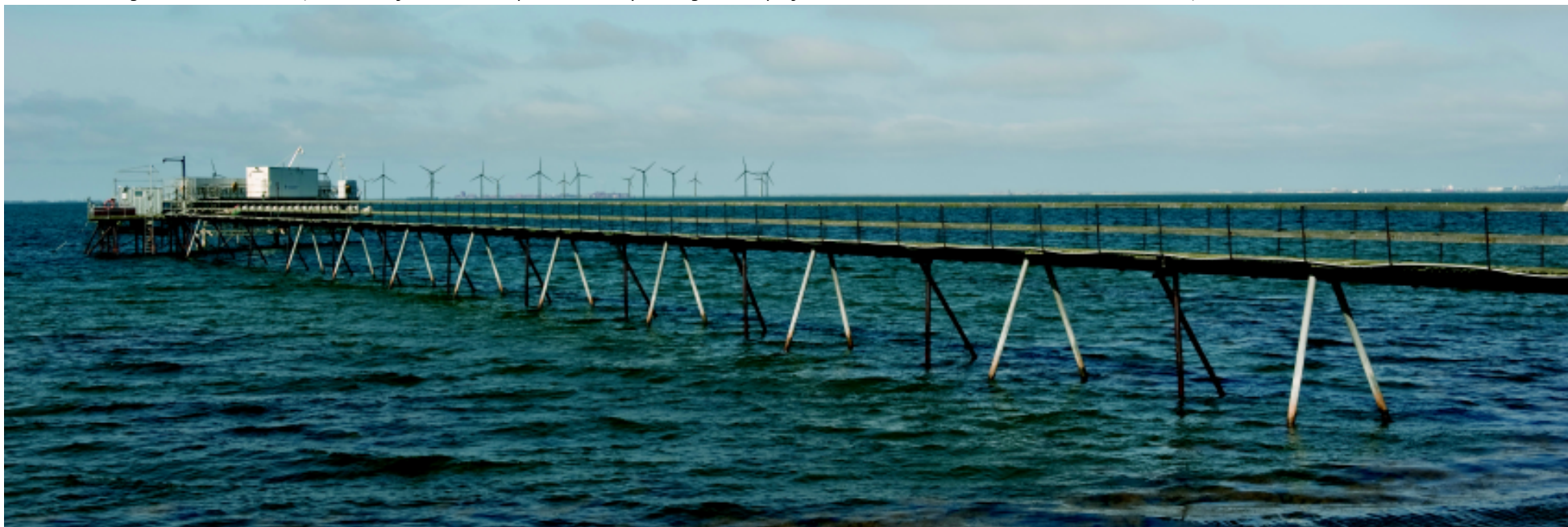
L3 Visualisering 11d med 12 stk 149,9 meter høje vindmøller opstillet i den sydvestlige del af projektområdet. Afstand til nærmeste vindmølle er 6,7 km.
