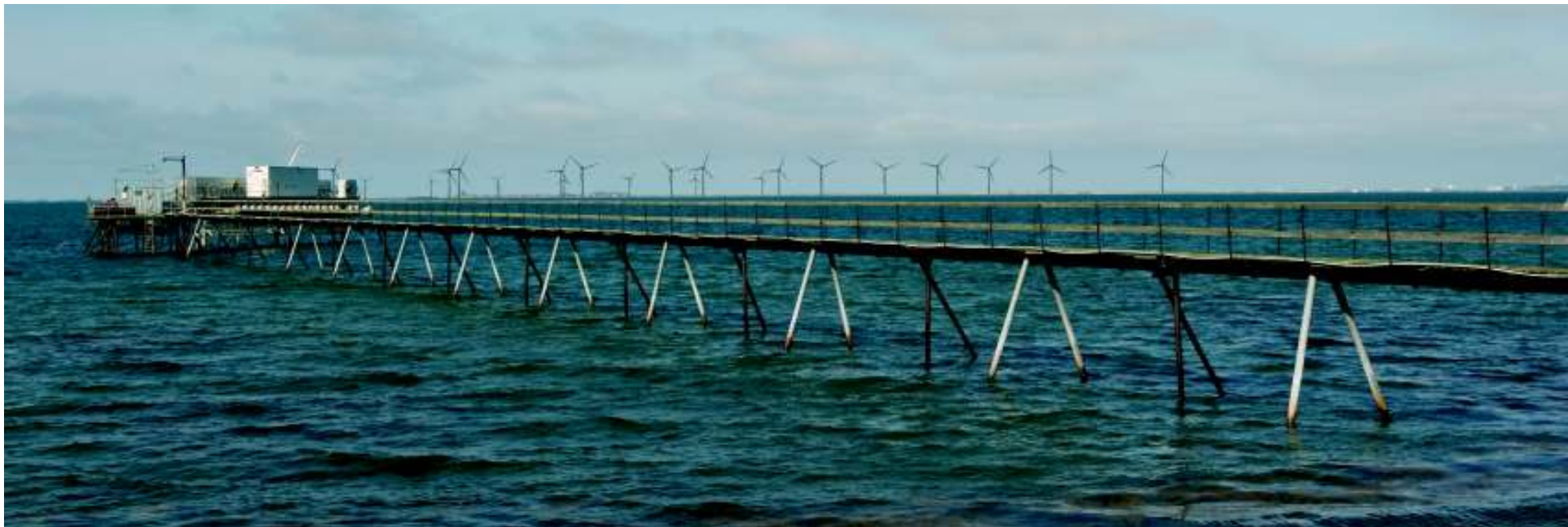
L2 Visualisering 11c med 14 stk 149,9 meter høje vindmøller opstillet i den nordøstlige del af projektområdet. Afstand til nærmeste vindmølle er 6,0 km.
