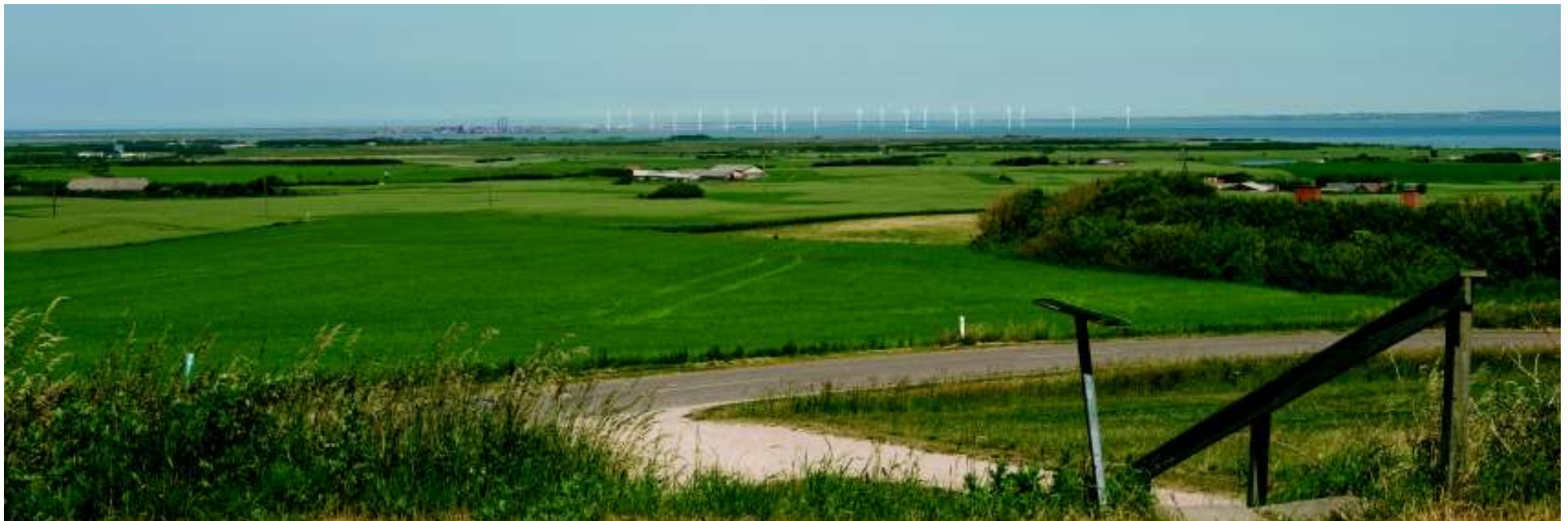
L3 Visualisering 15d med 12 stk 149,9 meter høje vindmøller opstillet i den sydvestlige del af projektområdet. Afstand til nærmeste vindmølle er 8,8 km.
