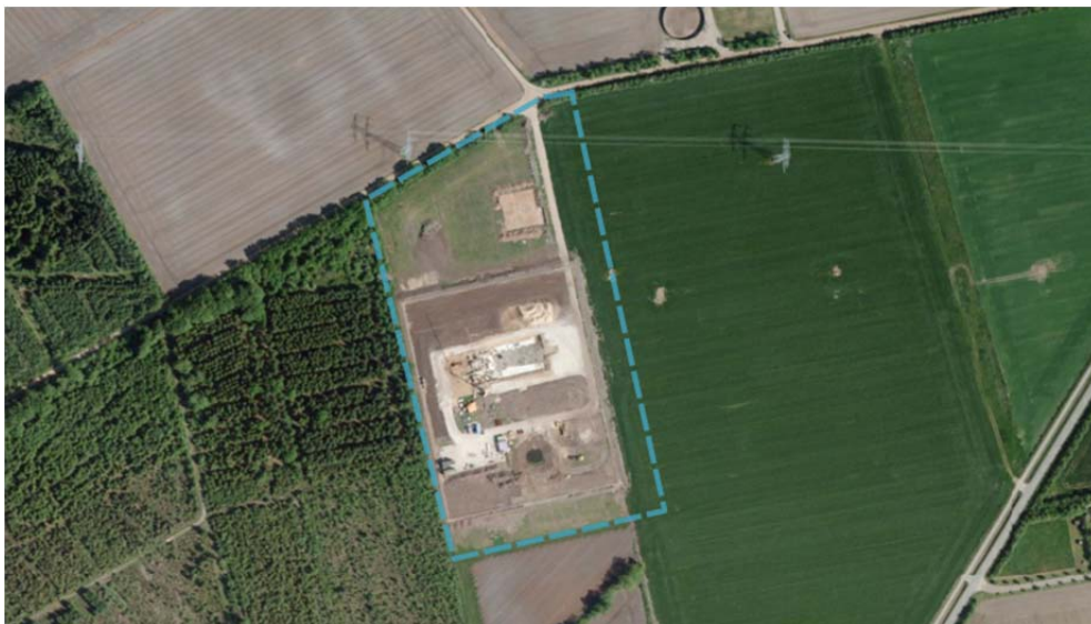
Figur 18.17. Transformerstation Revsing beliggende inden for lokalplanområdet (blå stiplede linje). Mod vest grænser stationen umiddelbart op til et fredskovs område.
