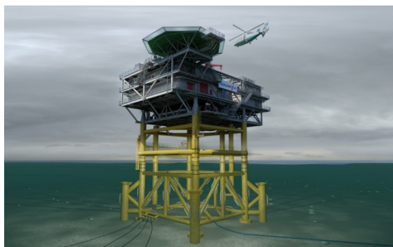
Model af transformerplatformen til Anholt Havmøllepark.
