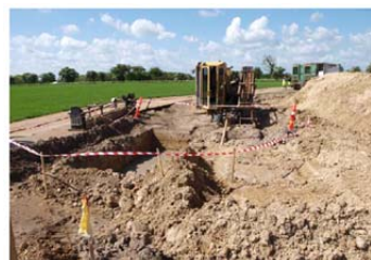
Eller kabelnedlægningen kan foregå ved styret underboring. Dette vil ske ved krydsning af naturområder og veje.
