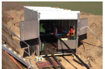
For hver kabellængde skal kablerne skal samles i en muffestation. Her etableres udstyr til overvågning af eltransmissionen.
