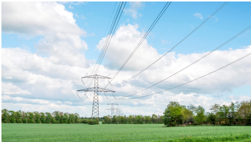
Figur 20.10. Det fremtidige højspændingsanlæg på strækningen mellem Holsted og Revsing, hvor det nuværende masteanlæg er suppleret med et nyt sæt dobbelt ledningssystem vist på masternes venstre side af billedet. Fotoet viser landskabet nord for Vejen fra vejen mod Læborg. Figuren i helsides format kan ses i visualiseringsrapporten (Orbicon, 2014b).
