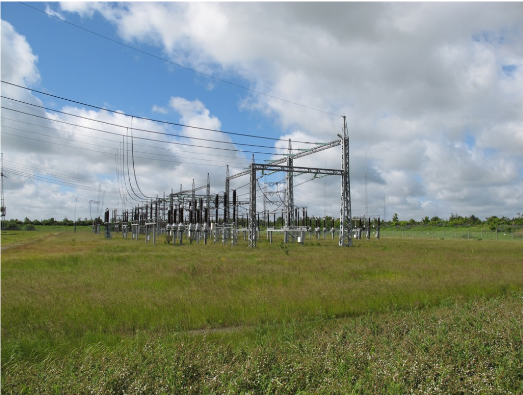
Stationsanlæg ved Endrup.
