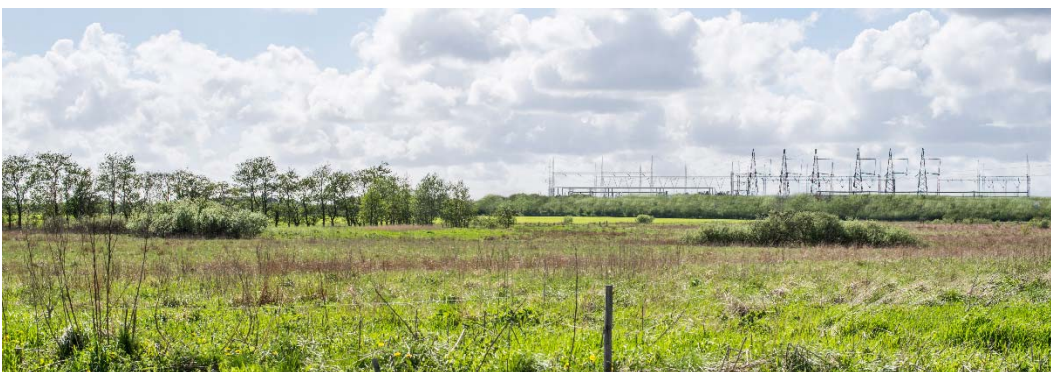
Figur 20.9. Udvidelsen af transformatorstationen ved Endrup vil set mod vest fra vejen mellem Endrup og Gammel Hjortkær komme til at virke næsten dobbelt så stort som tidligere. Dette selv når et nyt beplantningsbælte skjuler den nederste del af anlægget. Figuren i helsides format kan ses i visualiseringsrapporten, (Orbicon, 2014b).
