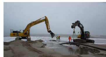
Gravemaskiner tager over og nedgraver kablet i strandplanet og forstranden.
