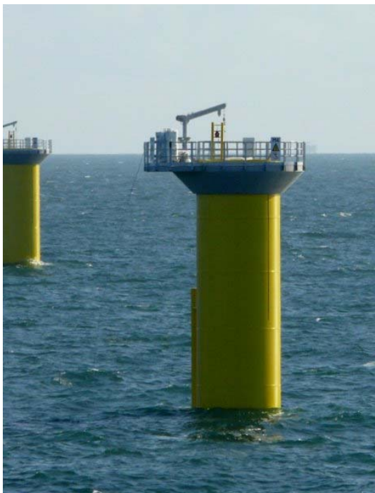
Havmøllefundament – monopæl - Horns Rev 2
