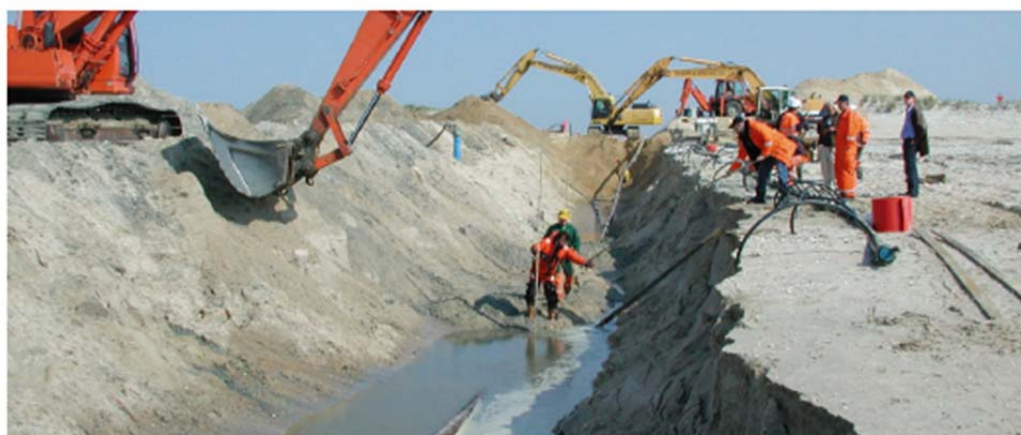
Figur 18.2. Udgravning af en kabelgrav på stranden.
