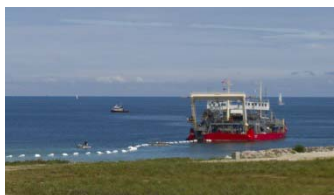
Kabellægningsfartøjet arbejder så tæt under land som muligt.
