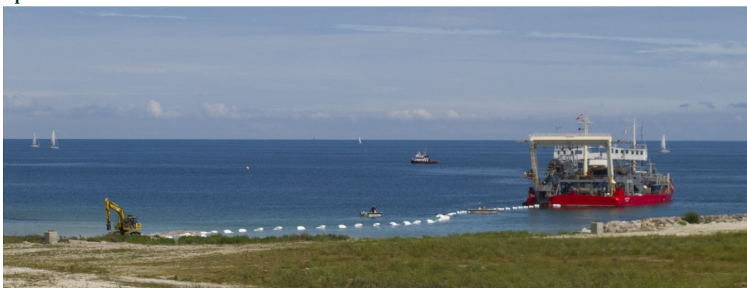
Kabellægningsfartøj der arbejder tæt under land
