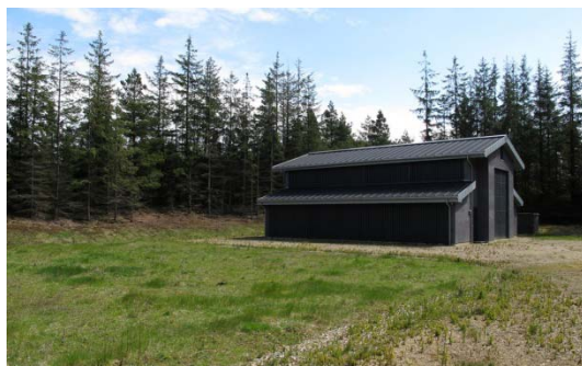
Figur 2.8. Kabelstation Blåbjerg, hvor koblingsanlægget er placeret indendørs.
