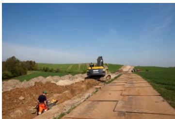
Arbejdsbælte omkring kabelgrav, med udlagte køreplader og opgravet muld- og råjord.
