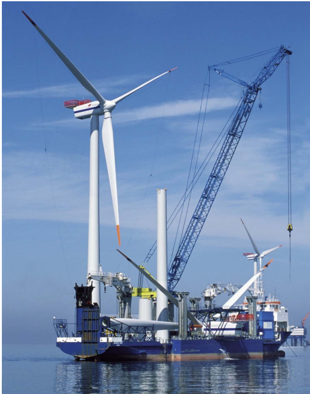
Montering af møller - Horns Rev 1
