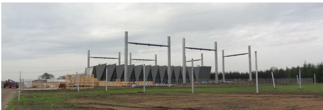
Figur 19.13. Transformerstation Revsing set fra nord med en eksisterende skov i baggrunden.
