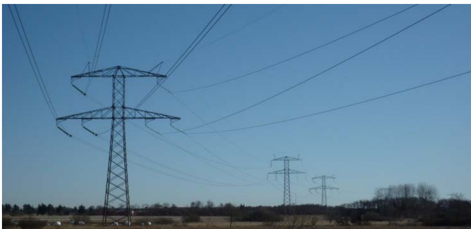
Figur 18.18. Eksisterende masterække af Donau-typen, som er forberedt til at bære et nyt 400 KV system.
