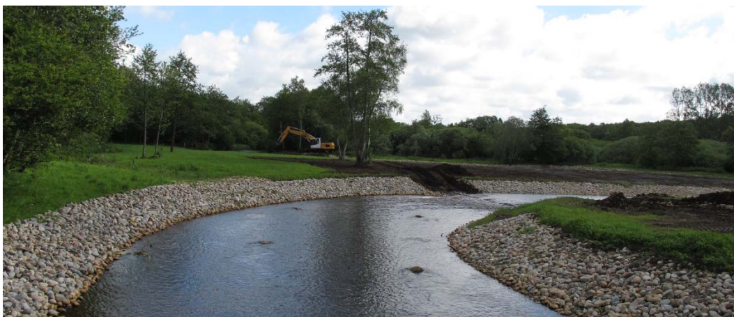
Varde Å hvor alternativet krydser den restaurerede strækning
