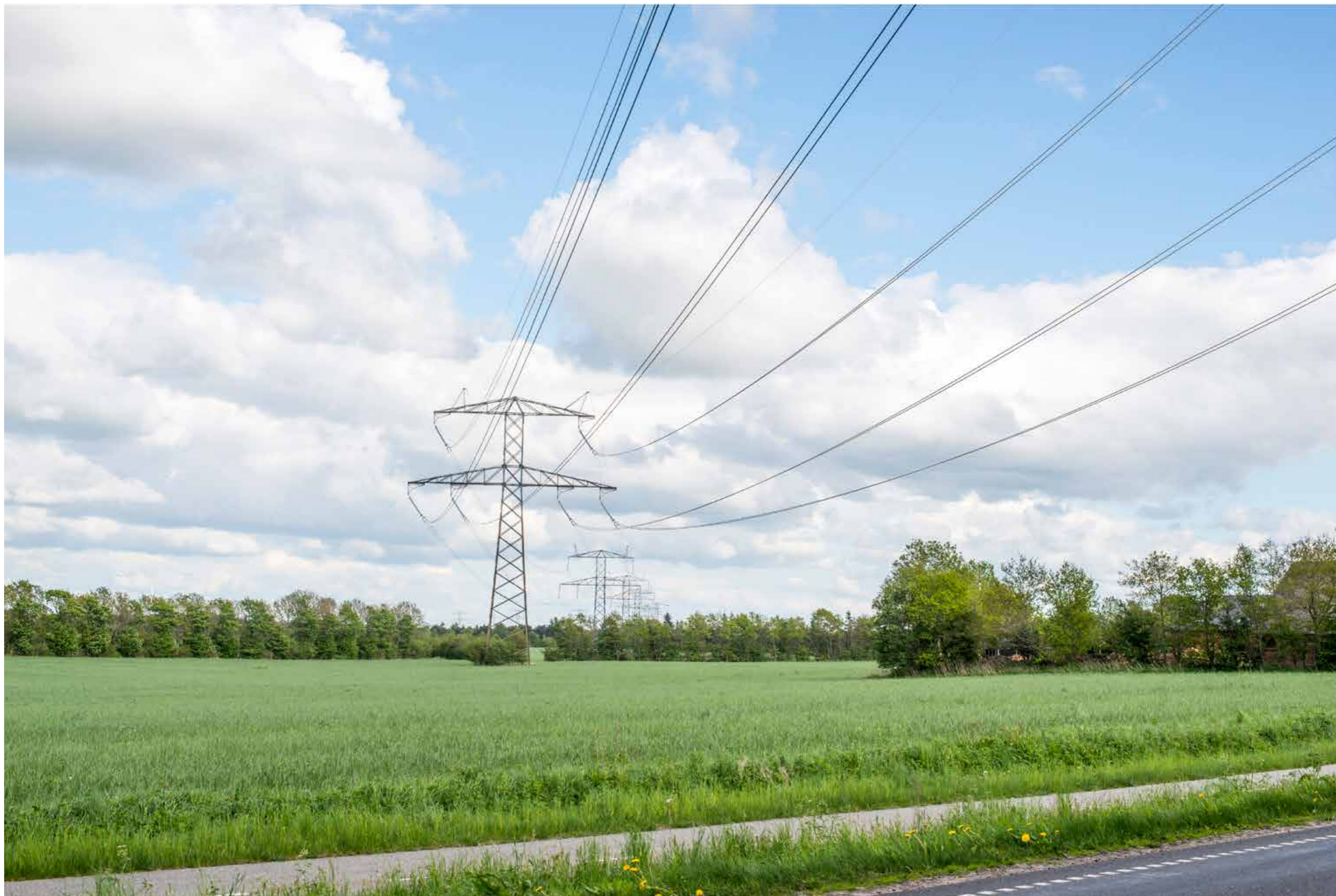
Fotostandpunkt E, højspændingsanlæg ved Læborg. Visualisering.
