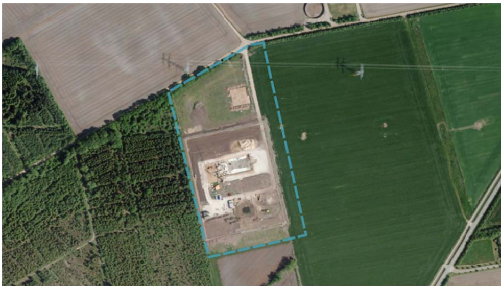
Figur 3.10: Transformestation Revsing (stationen er under opbygning). Lokalplanområdet er vist med blå stiplede streg
