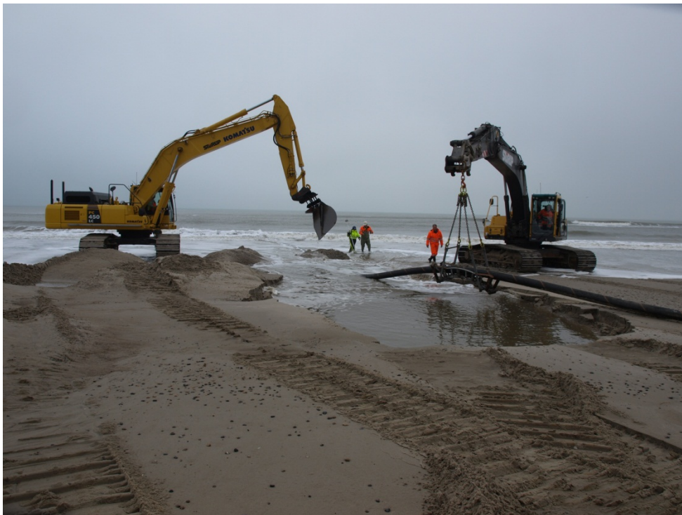
Figur2.13: Kabellægning i strandareal
