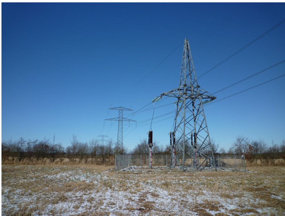
Figur 4.3: Kabelovergangsstation som demonteres
