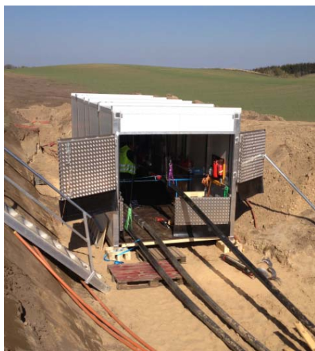
Figur 2.7: Montagecontainer placeret over en muffesamling
