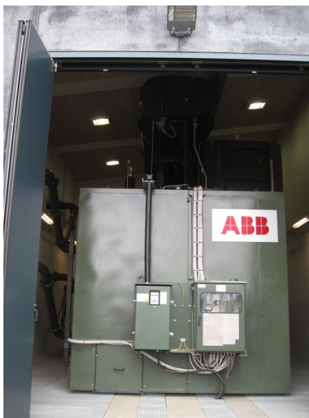
Figur 3.1: Kompenseringsspole
