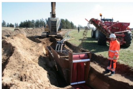
Figur 2.6: Kabelnedlægning med gravekasse
