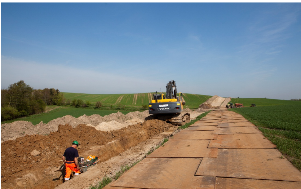
Figur 2.3: Eksempel på arbejdsbælte med afrømmet rå- og muldjord samt køreplader
