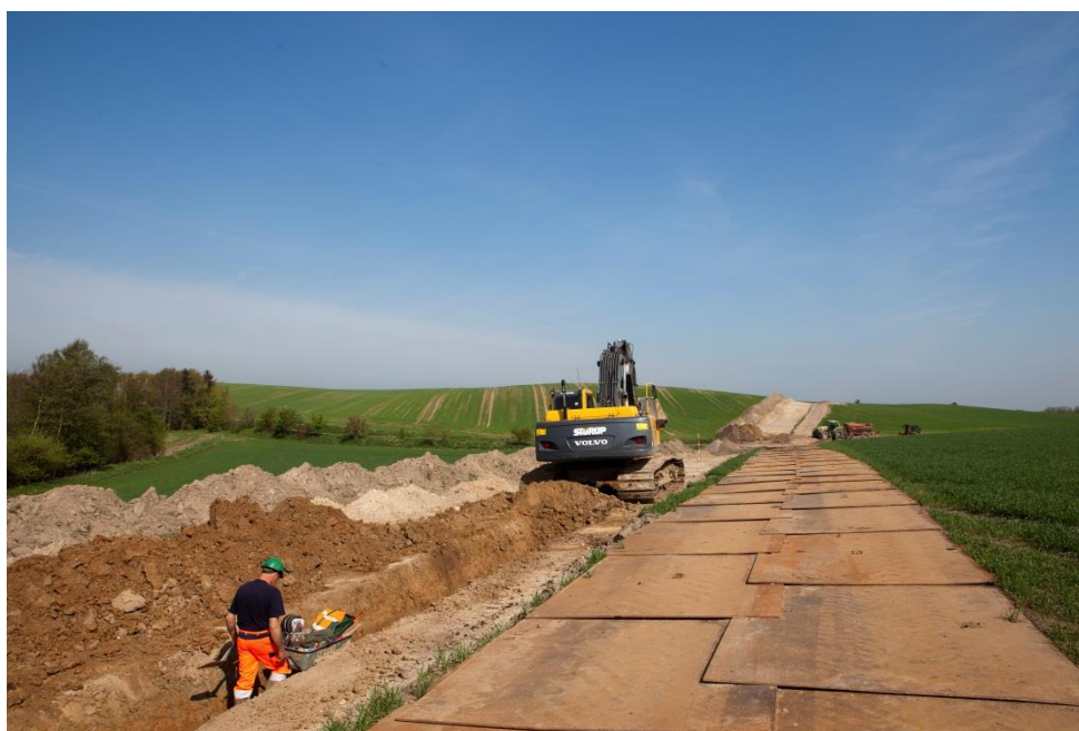
Udgravning af kabelgrav
