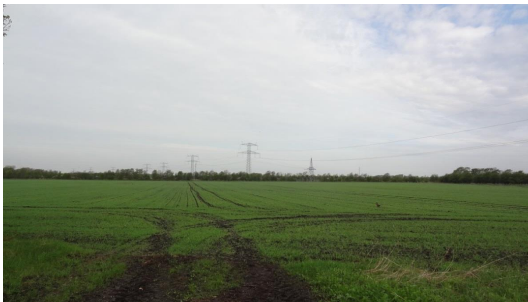
Figur 5.25. Master med ledere på én mastarm på landbrugsjord nord for station Holsted. Ved en opgradering af ledningssystemet vil lederne være symmetrisk fordelt på begge sider af masterne. Foto: Birgitte Kloppenborg-Skrumsager.
