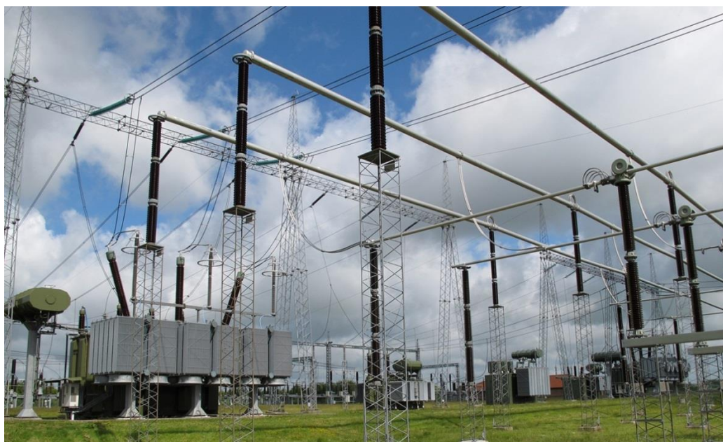
Stationsanlæg ved Endrup
