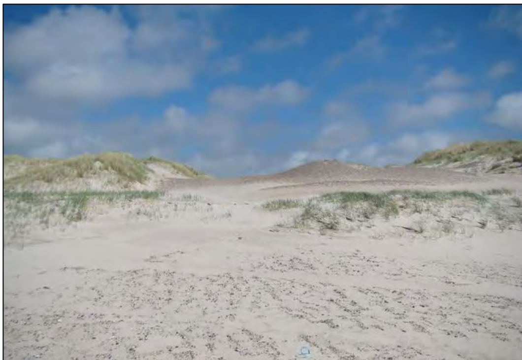
Stedet, hvor den styrede underboring af det eksisterende Horns Rev 2-kabelsystem påbegyndtes i den forreste klitrække (naturtype 2120).
