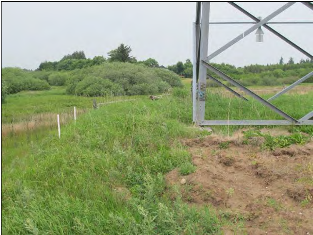
Mose ved Mast 98-1.
