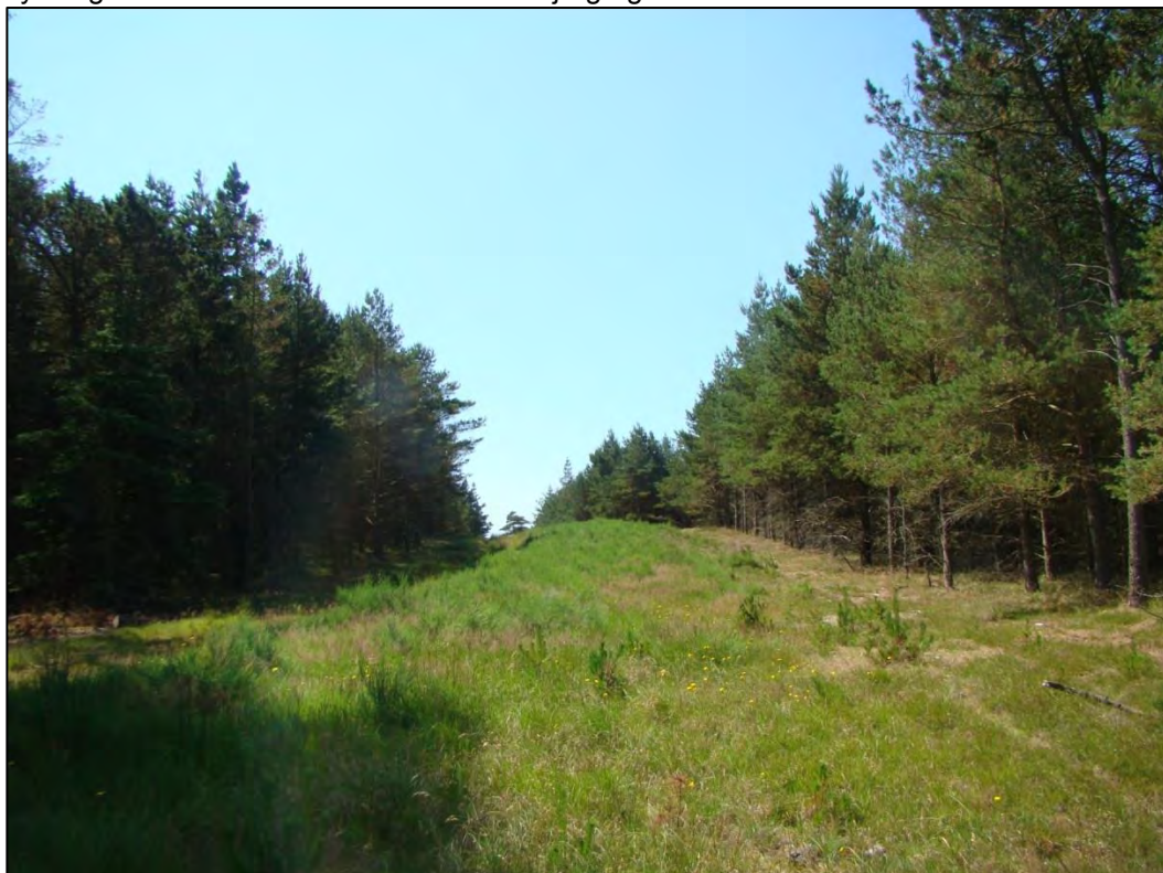
Kabeltraceet fra Horns Rev 2 gennem § 3 området Hede nr. 42 skal udvides i forbindelse med Horns Rev 3 kabelføringen.
