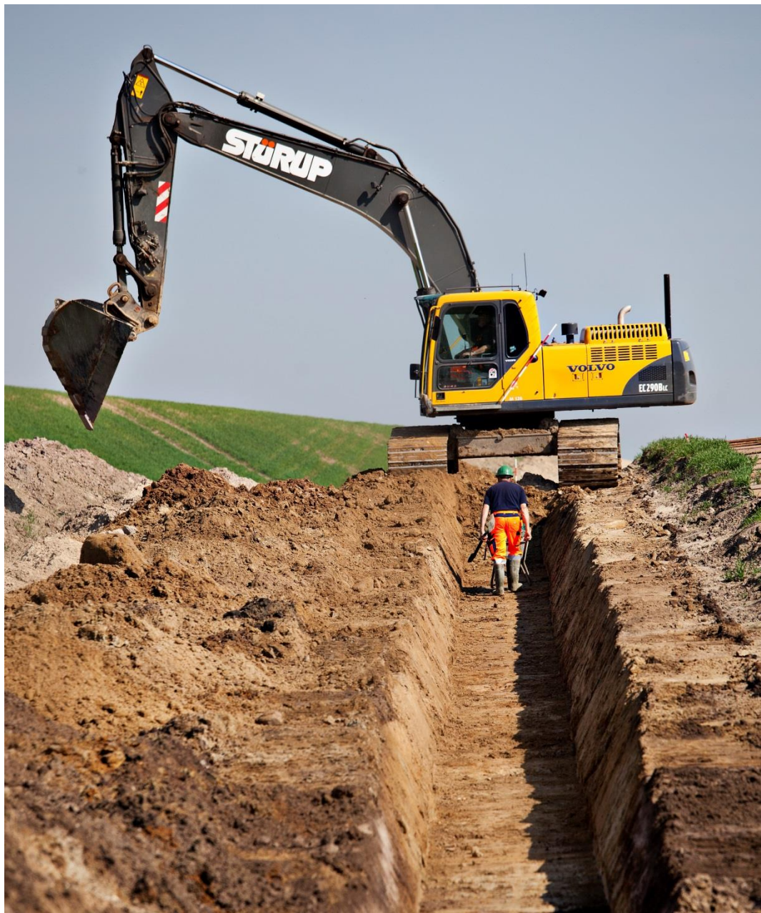
Etablering af kabelgrav
