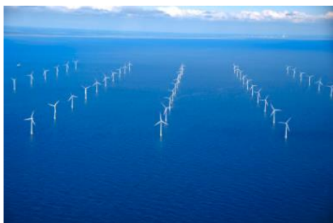
Havmølleparkens design ligger ikke fast, men fastlægges af den kommende ejer og bygherre for havmølleparken (foto: Energinet.dk).
