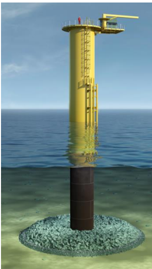
Figur 1-5. Et monopælfundament består af et stålrør, der er rammet ned i havbunden samt et gult overgangsstykke. På havbunden rundt om fundamentet er der etableret en erosionsbeskyttelse af store sten (Energinet.dk, 2015b).
