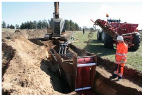
FIGUR 2-20 KABELNEDLÆGNING MED GRAVEKASSE.
