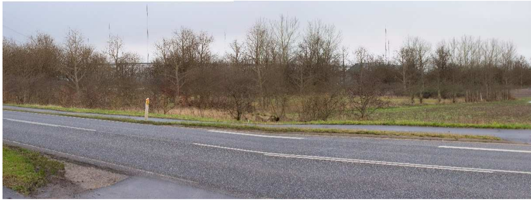
FIGUR 6-9 PLACERING AF DEN NYE STATION VED BJÆVERSKOV VEST ER SÆRLIGT SYNLIG I KRAFT AF LYNFANGSMASTERNE, MENS BEPLANTNINGSBÆLTET VIL MED TIDEN SKÆRME FOR DELE AF STATIONSANLÆGGET.
