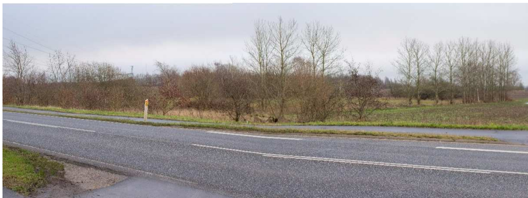
FIGUR 6-8 STATIONSPLACERINGS SET FRA VEST VED RINGSTEDVEJ. DEN EKSISTERENDE STATION SES KUN DELVIST, MENS LUFTLEDNINGERNE FORBUNDET TIL STATIONERNE DOMINERER DET VISUELLE UDTRYK.
