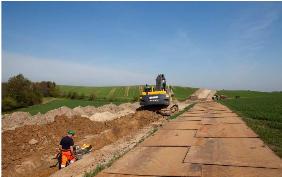
FIGUR 2-21 EKSEMPEL PÅ ARBEJDSBÆLTE MED AFRØMMET RÅ- OG MULDJORD SAMT KØREPLADER.
