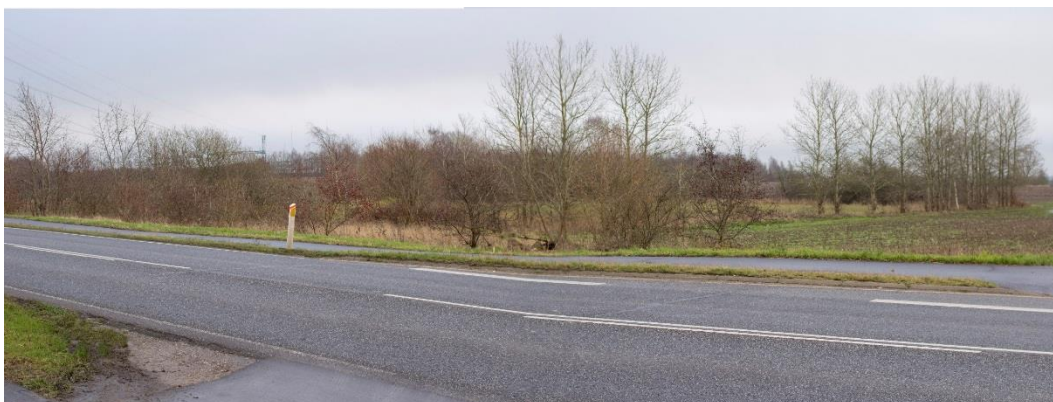
Figur 3-5. Foto af stationsplaceringen ved Bjæverskov Vest set fra vest ved Ringstedvej. Den eksisterende station ses kun delvist, mens luftledningen forbundet til stationen præger det visuelle udtryk.
