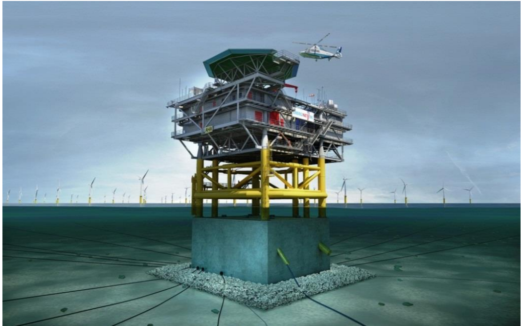
Figur 2-7. Hybridfundament.
