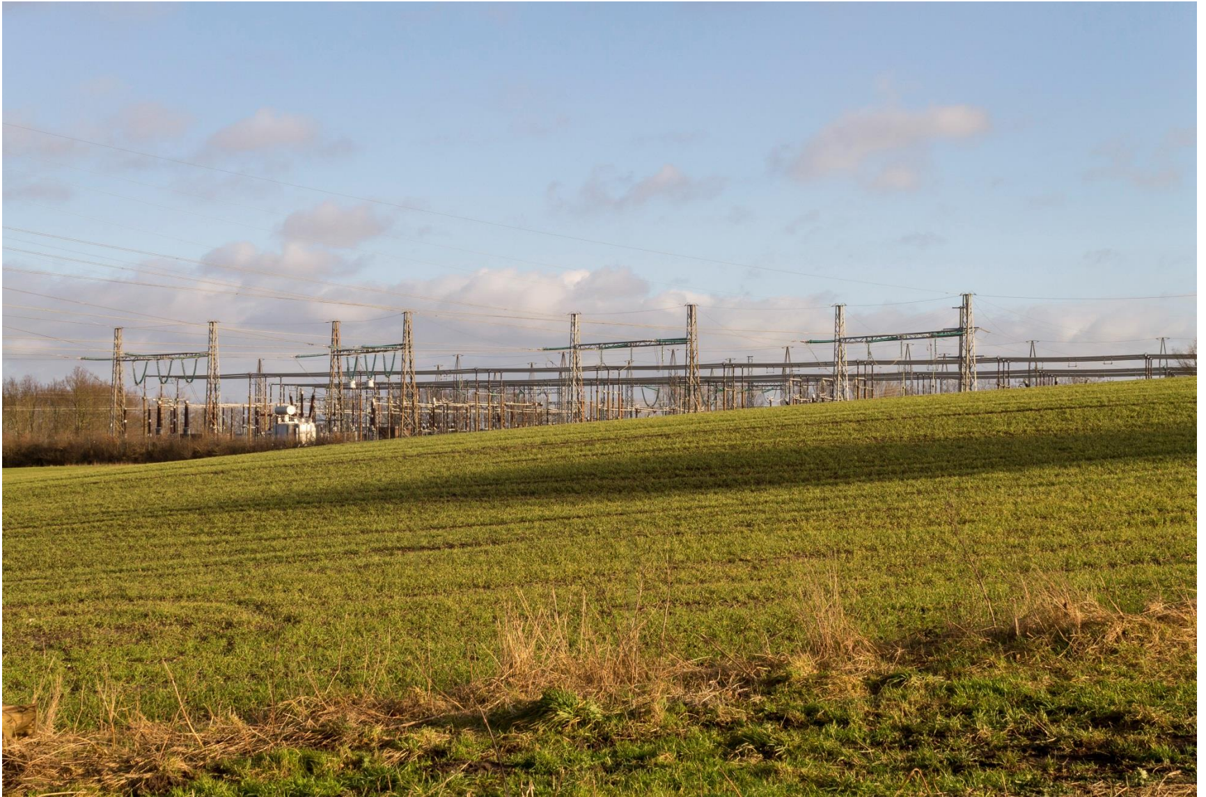
Figur 1-37 Fotopunkt D2, eksisterende situation. Station Hovegård set fra vest. Anlægget er tydeligt fra denne position, og fremstår med de mange master og kabler som et særdeles teknisk og markant anlæg.
