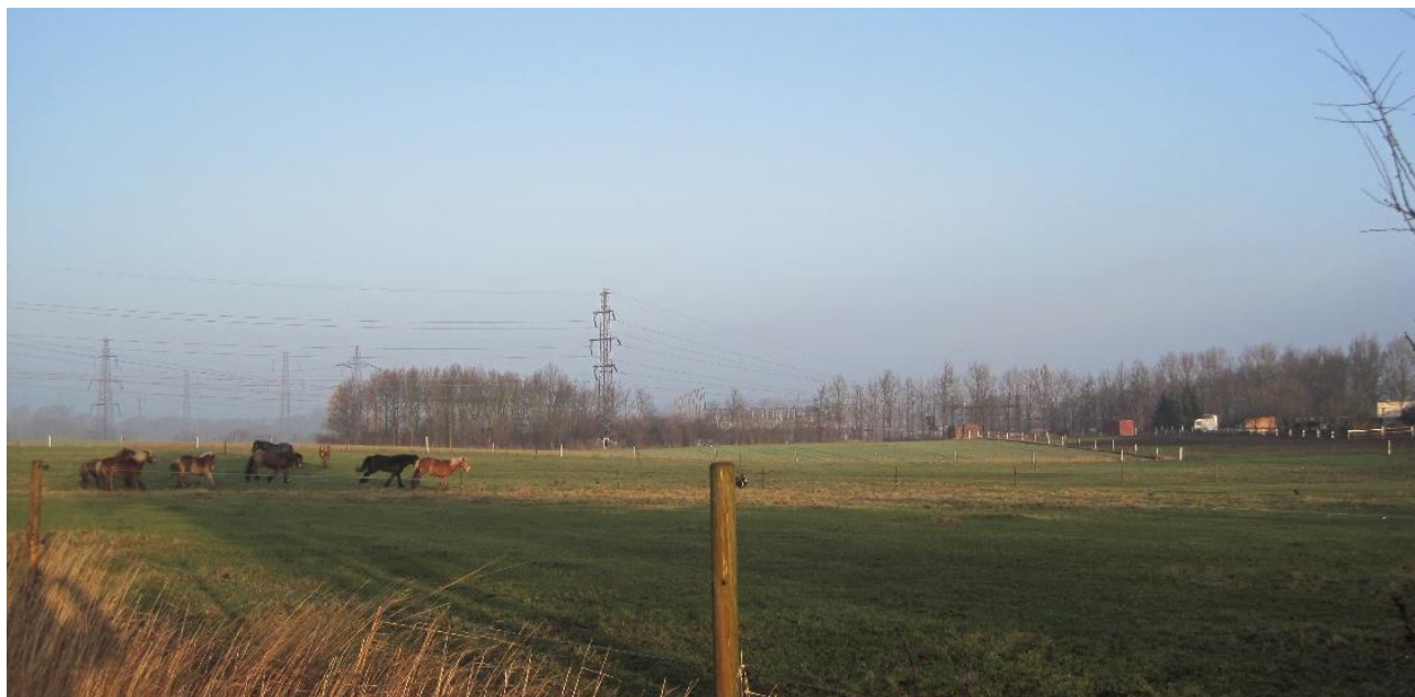
Figur 6-4 Station Hovegård ligger bag træbræmmen og er her set fra udkanten af landsbyen Hove. Visuelt præger de mange luftledninger og forskellige master, der leder til og fra stationen.
