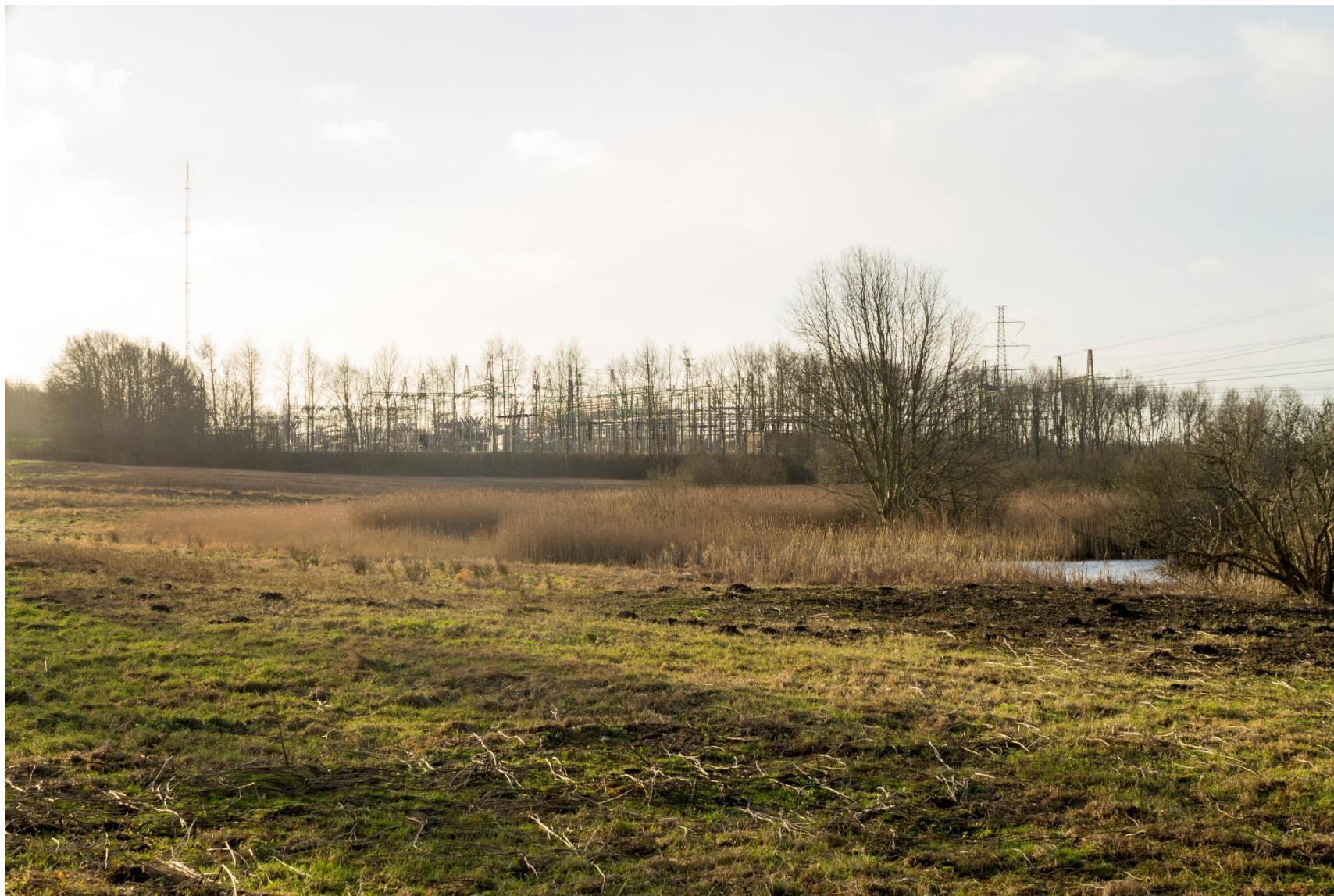
Figur 1-42 Fotopunkt D4, visualisering. Station Hovegård set fra nord. Udbygningen kan anes centralt i billedet. De nye elementer er stort set ikke synlig, men indgår visuelt også fra denne position som en del af det eksisterende anlæg.
