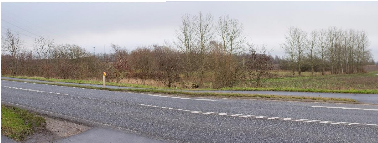
Figur 5-23 Fotopunkt B1, eksisterende situation. Stationsplaceringen set fra vest ved Ringstedvej. Den eksisterende station ses kun delvist, mens luftledningerne forbundet til stationerne dominerer det visuelle udtryk.
