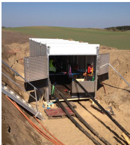
Figur 2.12 Montagecontainer placeret over en muffesamling
