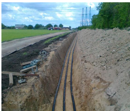
Figur 2.10 Eksempel på en kabelgrav lige efter udtrækning af kabler
