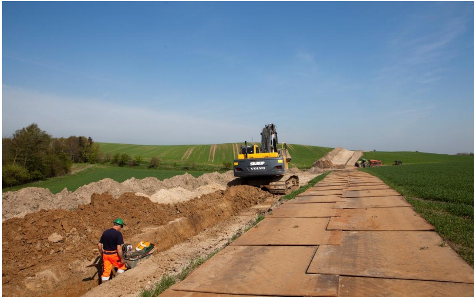
Figur 2.8 Eksempel på arbejdsbælte med afrømmet rå- og muldjord samt kørelader
