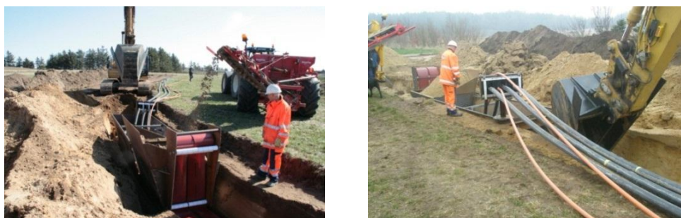
Figur 2.11 Kabelnedlægning med gravekasse
