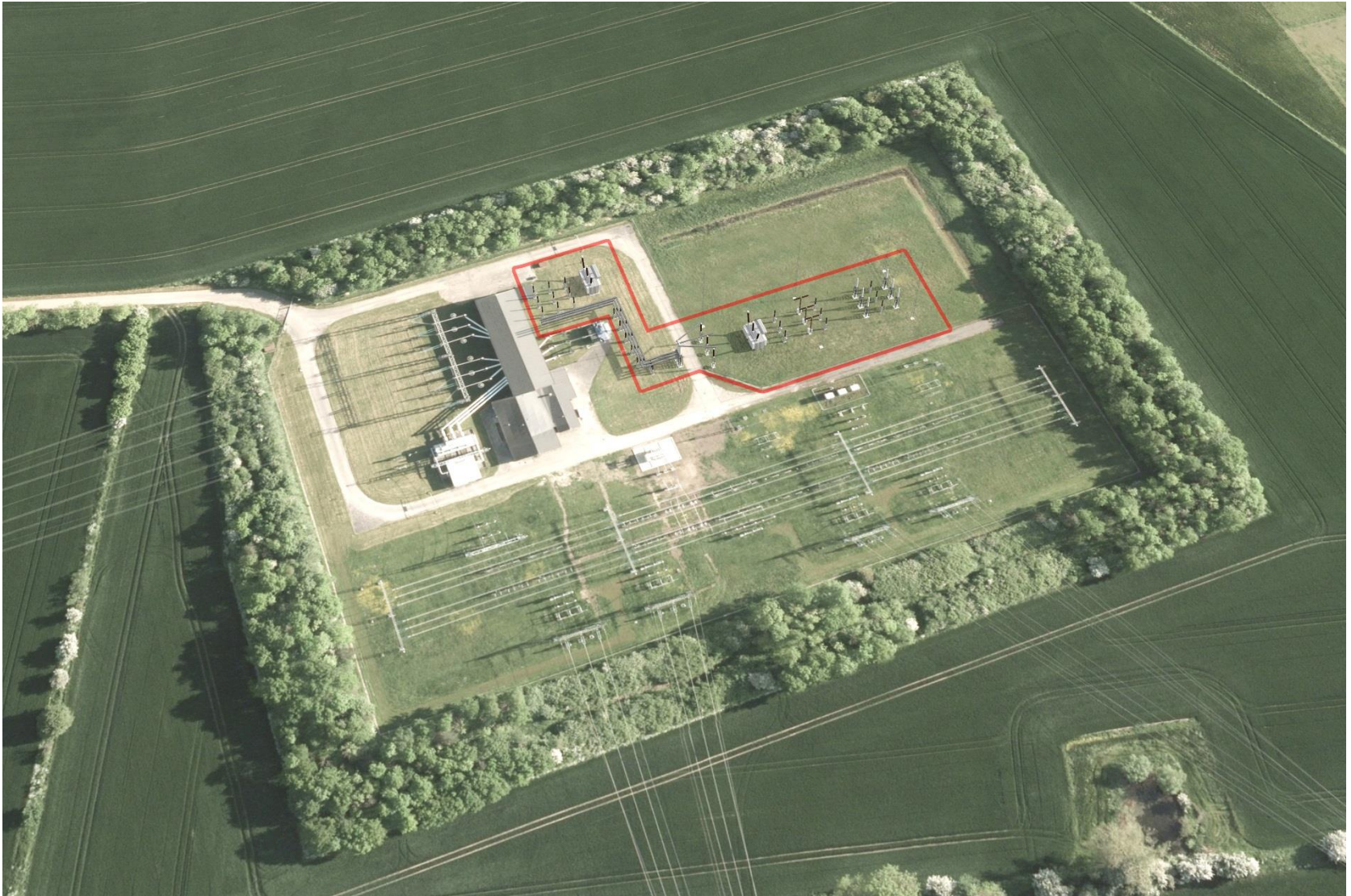
Figur 1-27 Illustration af station Ishøj set fra vest. De nye elementer er markeret med rødt og består af en ny reaktor ved bygningen og et nyt transformerfelt med transformere samt nye lynfangsmaster, som her bliver 15 m høje. Figuren er baseret på 3D-model af anlægget og danner grundlag for visualiseringerne
