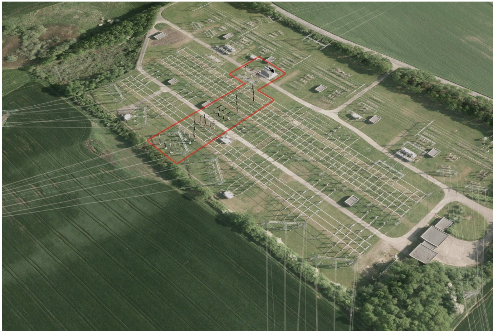
Figur 1-34 Illustration af station Hovegård set fra sydvest. De nye elementer er markeret med rødt og ses som mørkere pæle centralt i station og udgøres af et nyt transformerfelt (som de eksisterende) og skinner op til 11 m høje. Herudover en transformer øverst i billedet. Der tilføjes ikke flere lynfangsmaster. Figuren er baseret på 3D-model af anlægget og danner grundlag for visualiseringerne
