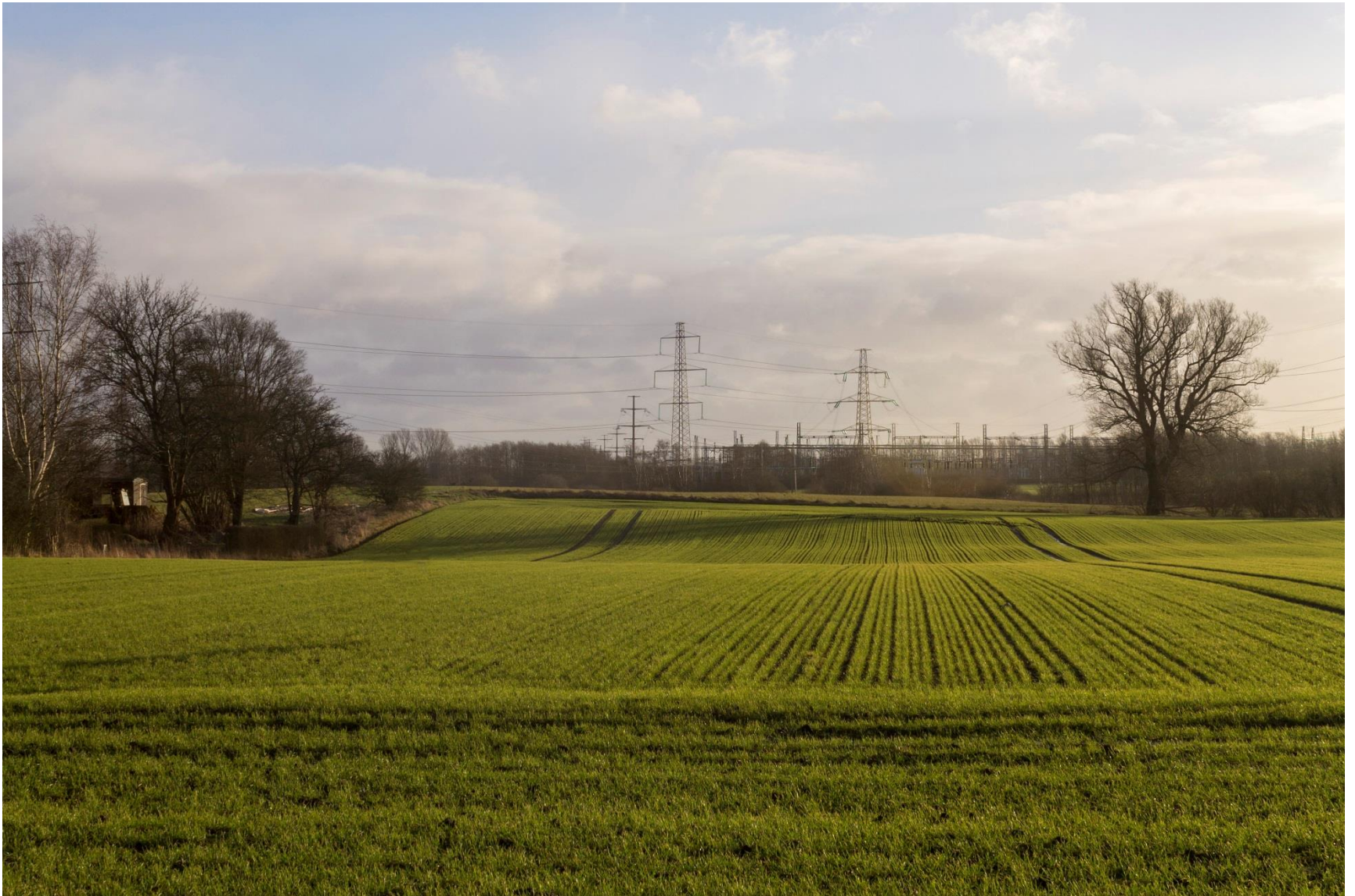
Figur 1-40 Fotopunkt D3, visualisering. Station Hovegård set fra nordvest. Udbygningen kan anes til venstre for det store træ. De nye elementer er stort set ikke synlig, men indgår visuelt som en del af det eksisterende anlæg.
