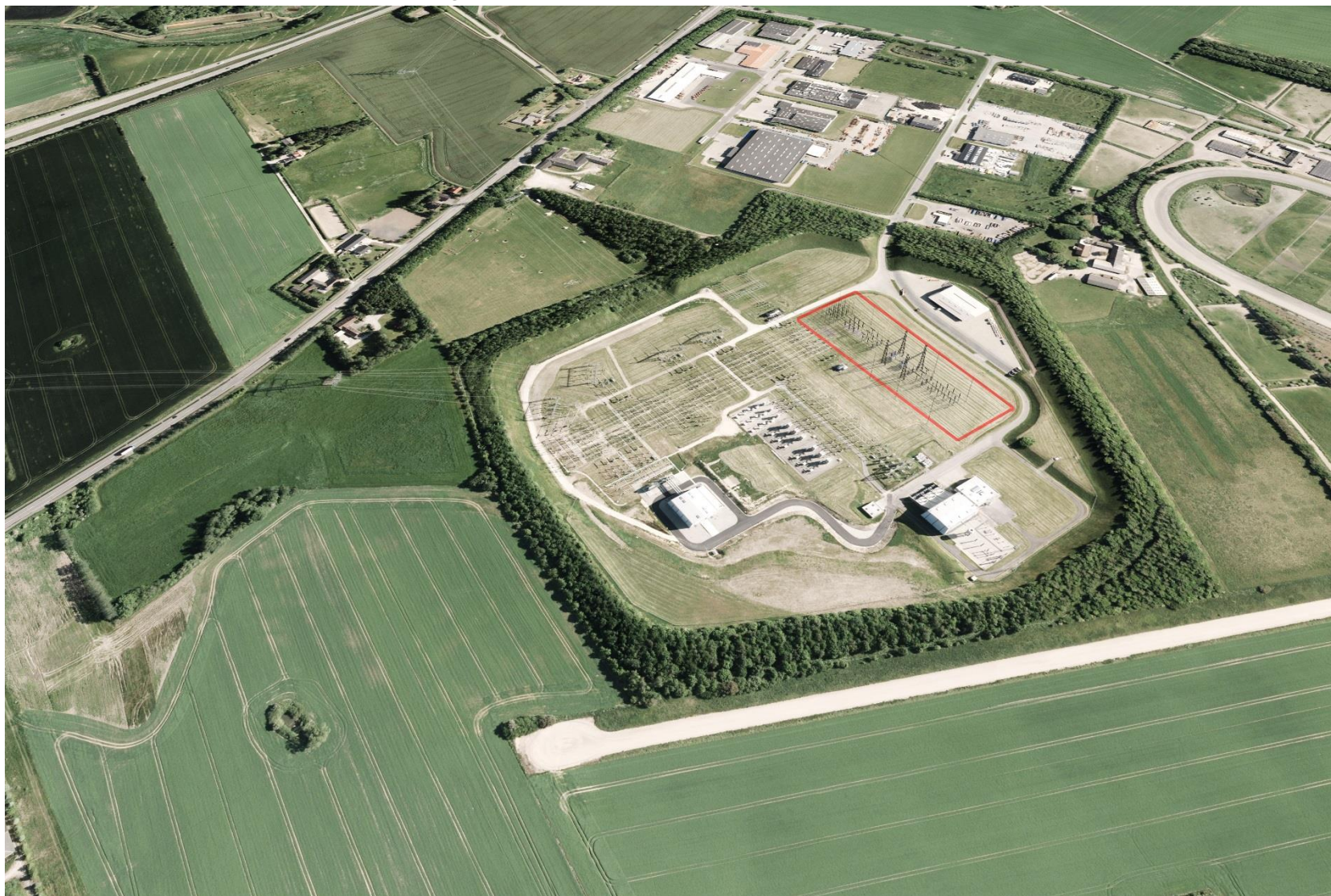
Figur 1-19 Illustration af udbygning af station Bjæverskov set fra sydvest. De nye elementer er markeret med rødt og består af fire master (20 m), syv lynfangsmaster (28 m), skinner og andre tekniske installationer (ca. 11 m). Figuren er baseret på 3D-model af anlægget og danner grundlag for visualiseringerne
