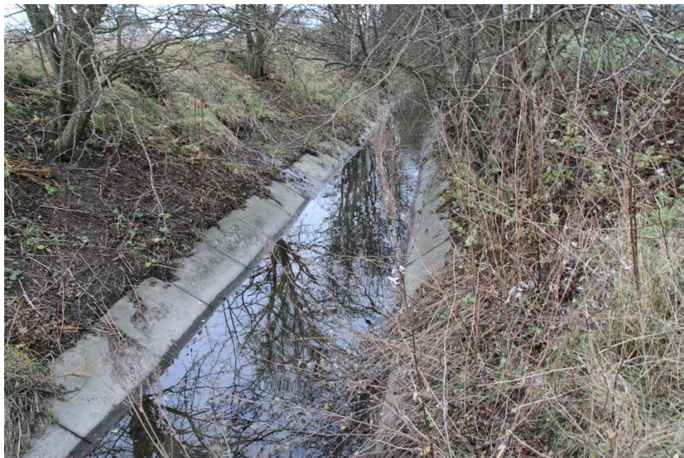
Figur 4-10 Baldersbæk og dele af Lille Vejle Å er fikseret med beton. De vurderes at disse strækninger er uden biologisk værdi af betydning. Fotodato: 2. december 2014.
