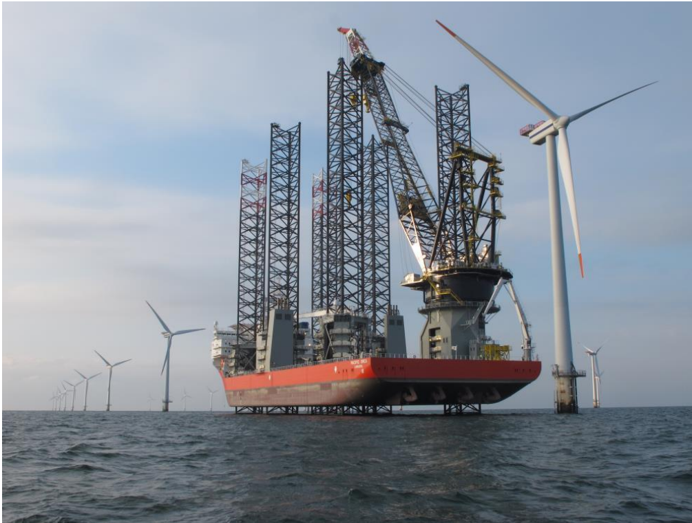
Figur 3-5. Installation af vindmøller med jack-up fartøj. Foto: Swire Blue Ocean (Energinet.dk, 2015d).
