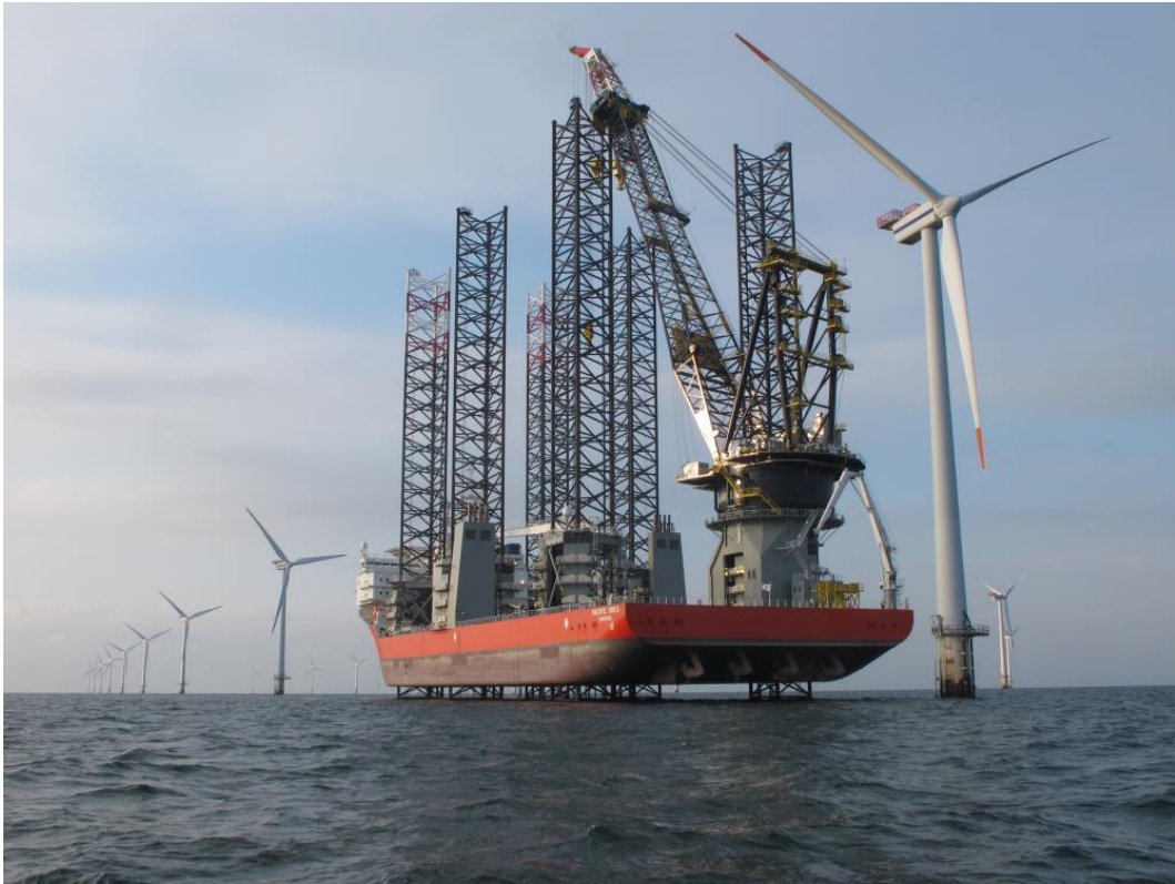
Figur 3-5. Installation af vindmøller med jackup fartøj. Foto: Swire Blue Ocean (Energinet.dk, 2015).
