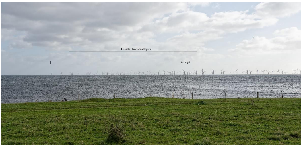
Figur 4-25 Illustration af de kumulative effekter set fra østkysten på Djursland. Illustrationen er et panorama rækker dermed langt ud over fokuserede synsfelt. I sammenhæng danner Hesselø Havvindmøllepark og Kattegat én stor havvindmøllepark. Hesselø Havvindmøllepark er illustreret med 20 MW møller med en totalhøjde på 310 meter. (NIRAS A/S 2024c)
