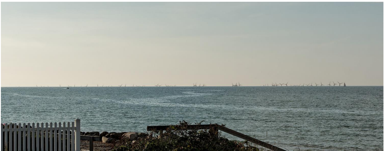
Figur 6.2: Udsnit af visualiseringen fra standpunkt 1, Gilleleje Veststrand, der viser et eksempel på en opstilling med 20 MW møller. Der er her zoomet ind på opstillingen for at tydeliggøre, hvordan havvindmølleparkens trekantopstilling skaber et perspektiv, hvor de nærmeste møller centralt i opstillingen optræder væsentligt højere end møllerne i siderne og bagerst i opstillingen. Den samlede havvindmøllepark opfattes derved som et bueslag mod himlen. Bemærk at figuren alene illustrere opstillingen og at den anvendte beskæring ikke gengiver en korrekt visualisering.
