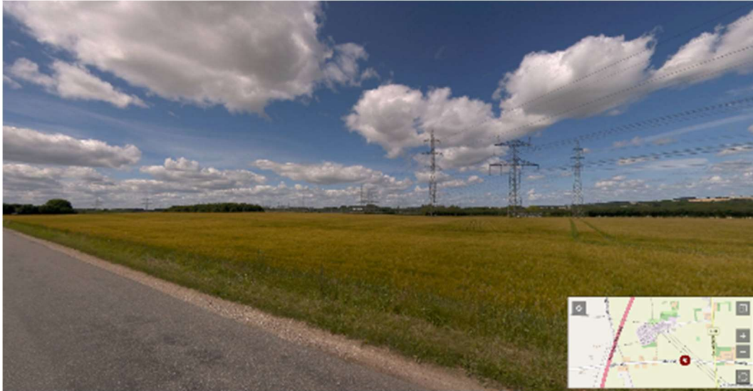
Figur 6-49 Station Trige set fra sydøst fra Hæstvej tæt ved krydset med Randersvej. Kilde: COWI Gadefoto (2022).
