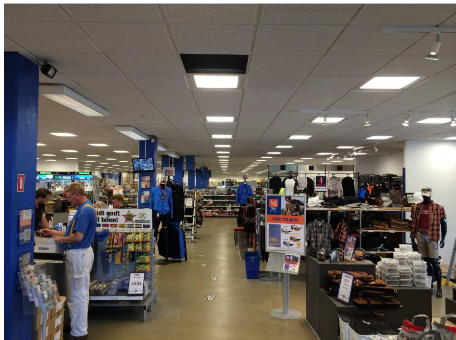
Figur 7-17 Belysningsanlæg med 38W LED-lyskilder.
