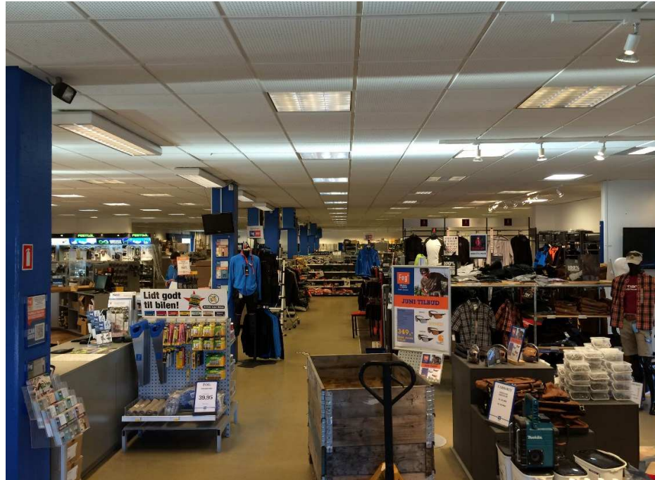
Figur 7-17 Belysningsanlæg med 38W LED-lyskilder.
