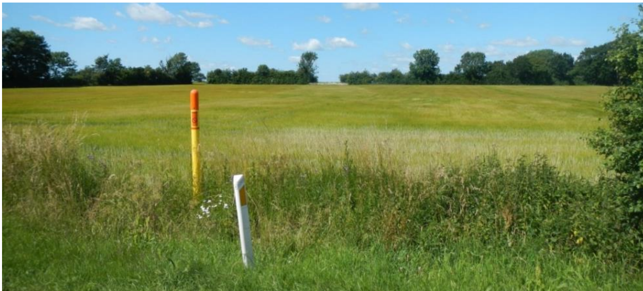
Figur 5-17 Gasrørledning i driftsfasen. Den gul/orange pæl er en markeringspæl, som angiver placeringen af centeret af gasrørledningen. Konsekvensen af servitutten omkring gasrørledningen ses som et mellemrum i det levende hegn i baggrunden, da der ikke må være træer ovenpå ledningen.
