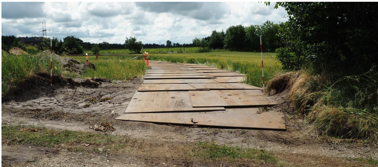
Figur 1-9 Eksempel på gennemgravning af beskyttet jorddige.
