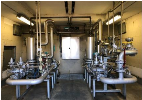
Figur 5-19 Venstre billede; eksempel på MR-station set indefra. Højre billede; kompressor med køler.
