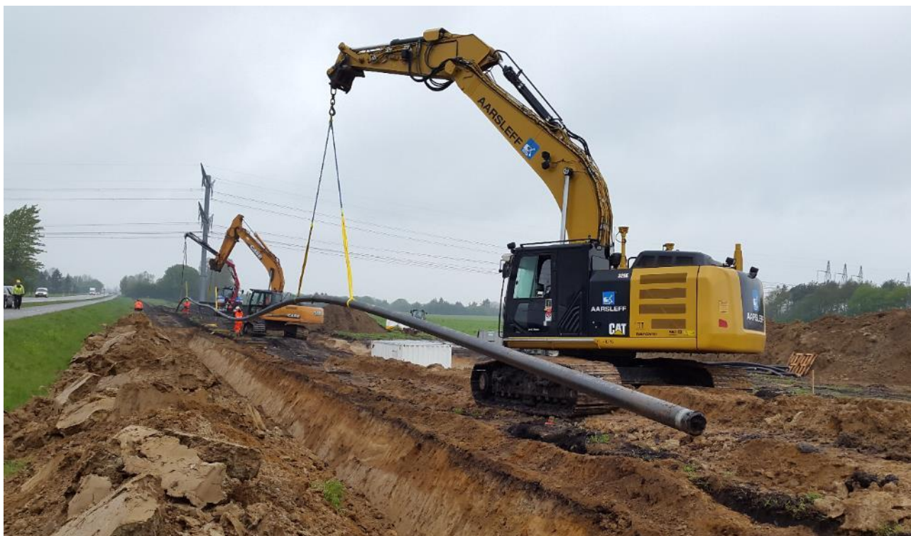
Figur 5-4 Nedlægning af gasrørledning i rørgrav.
