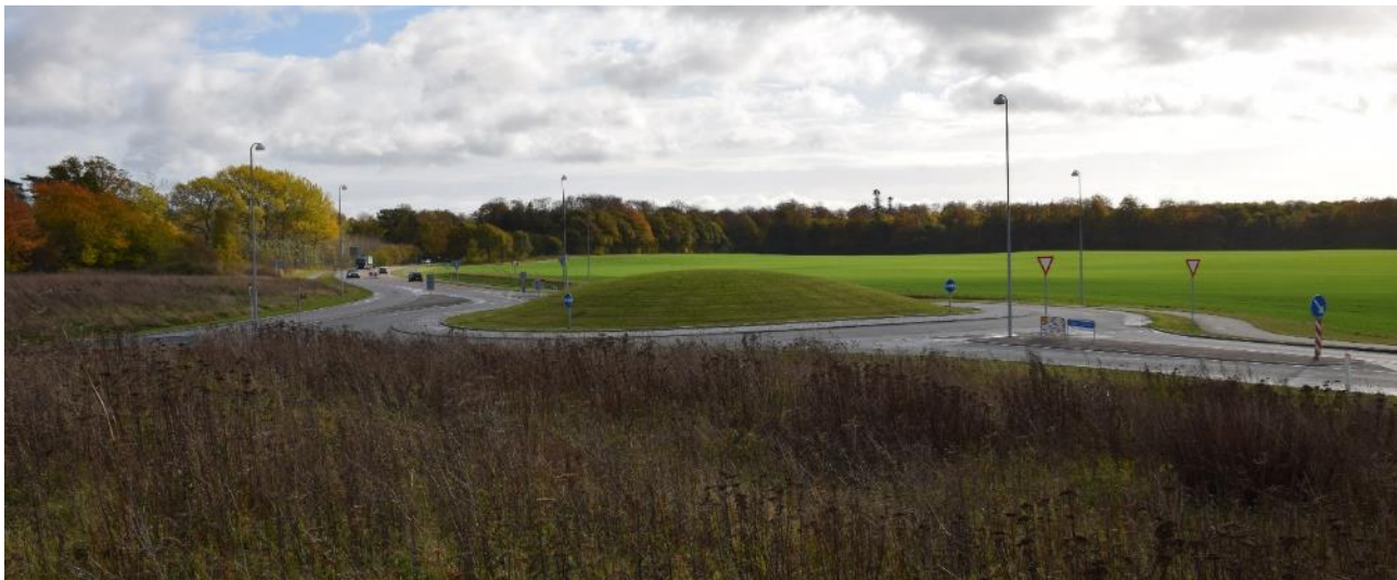
Figur 12-4 Rundkørsel ved Gedser Landevej. I baggrunden ses Hallerup Skov.
