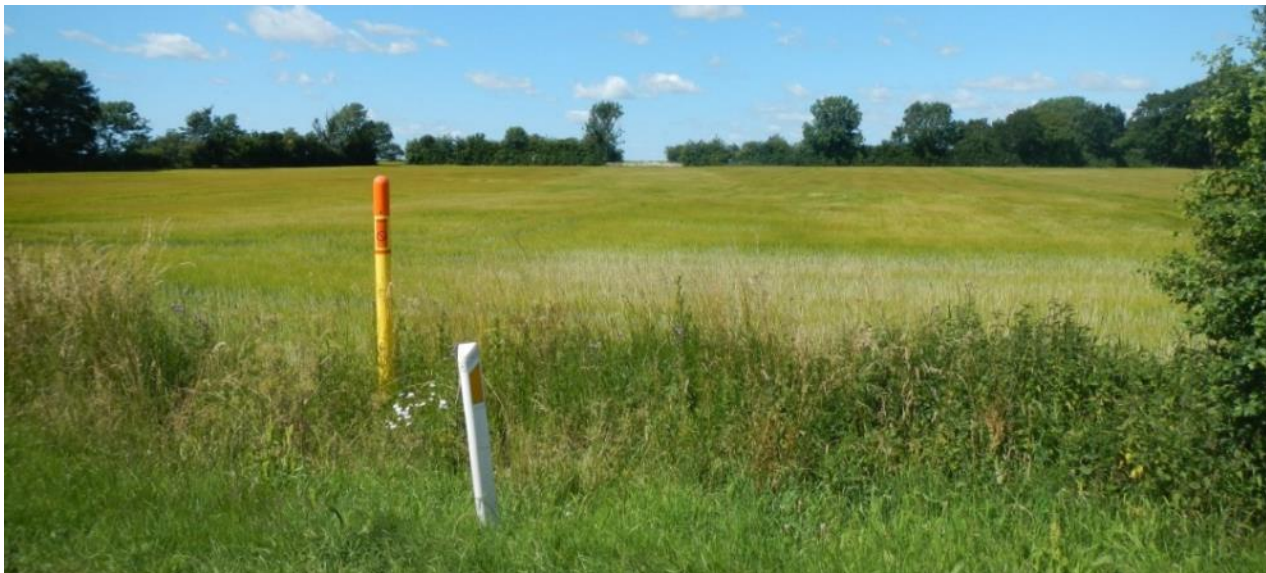
Figur 1-5 Gasrørledning i driftsfasen. Den gul/orange pæl er en markeringspæl, som angiver placeringen af centeret af gasrørledningen. Konsekvensen af servitutten omkring gasrørledningen ses som et mellemrum i det levende hegn i baggrunden, da der ikke må være træer ovenpå ledningen.
