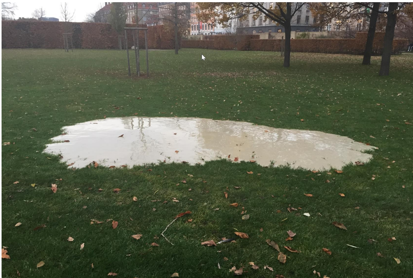
› Figur 17-27 Eksempel på udsivet boremudder fra et blow-out på en græsplæne.
