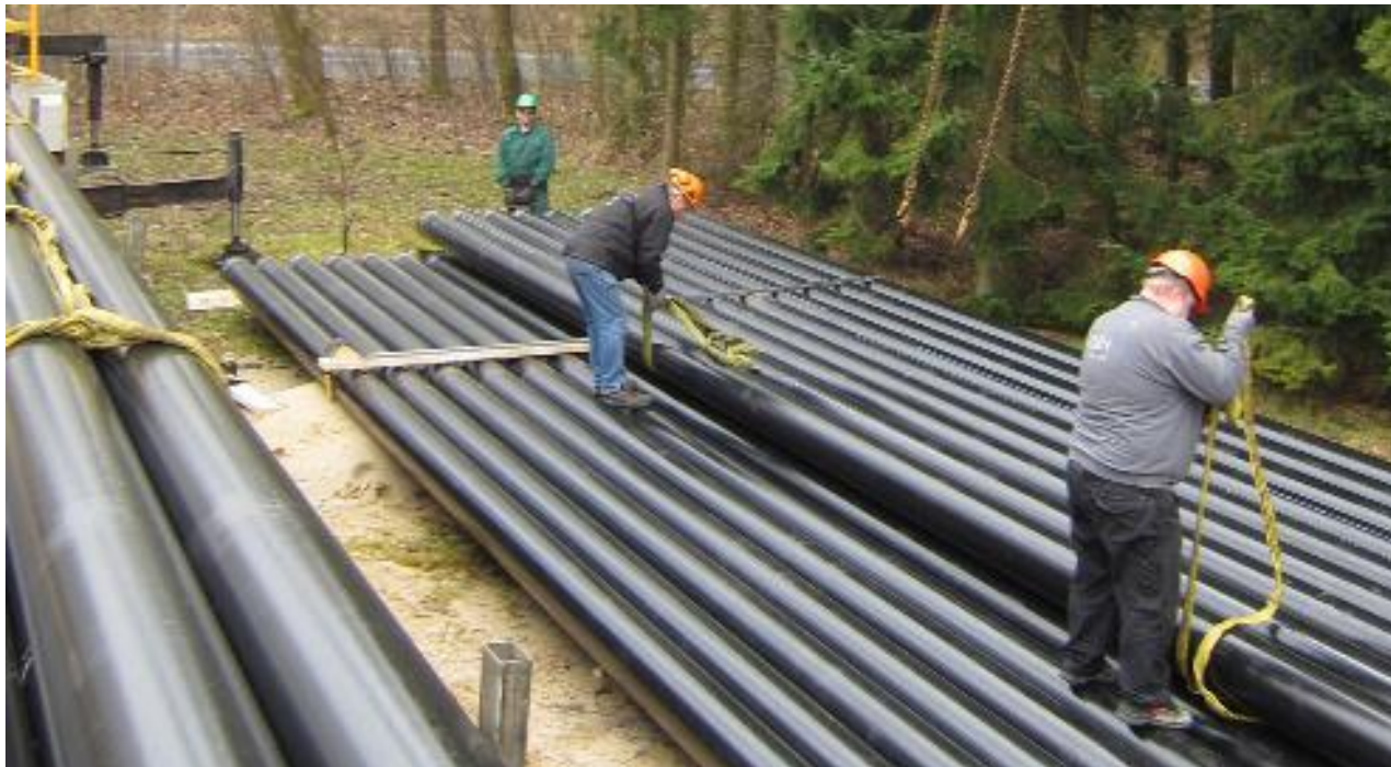
Figur 5-10 Håndtering af rør på oplagsplads.
