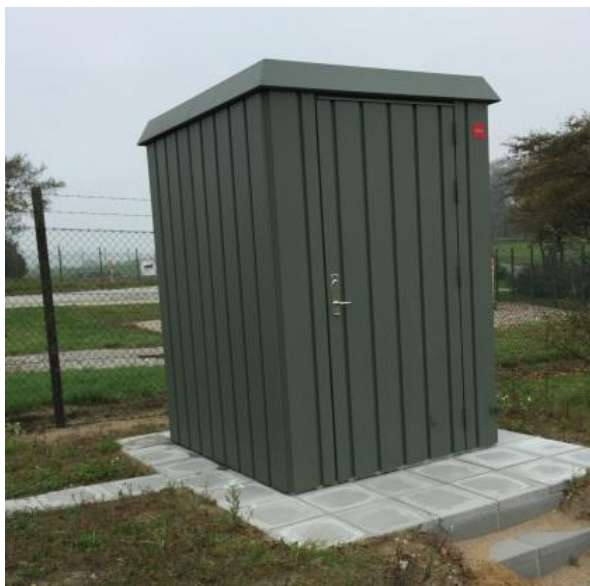
Figur 5-20 Elskab for katodisk beskyttelse.
