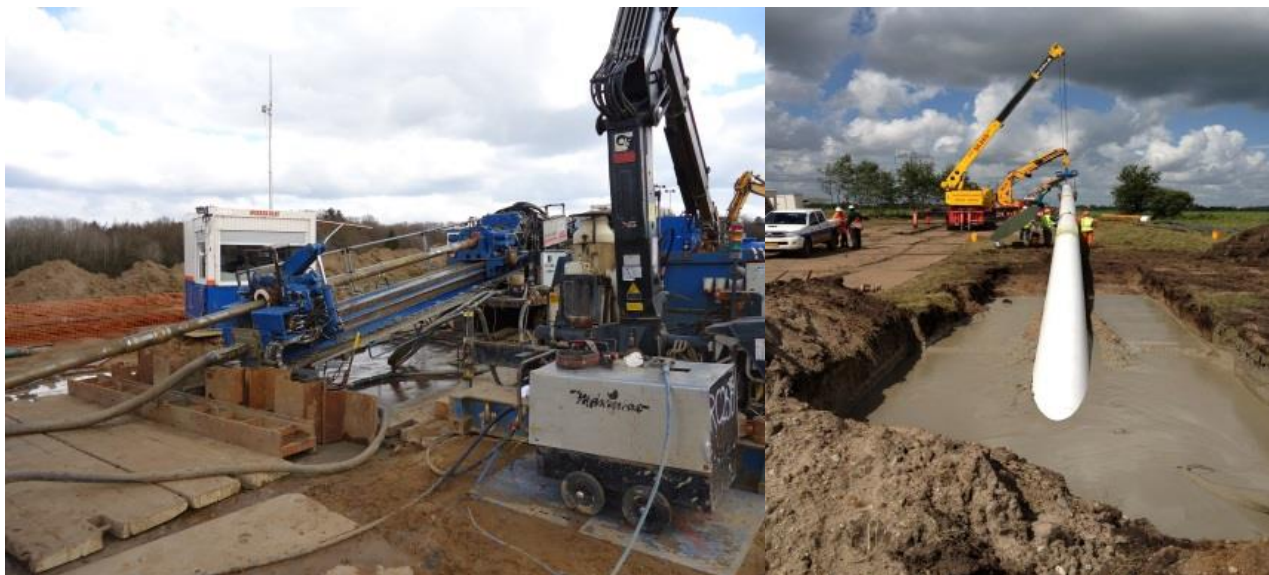
Figur 5-12 Boremaskine for styret underboring og gasrørledning under installering.
