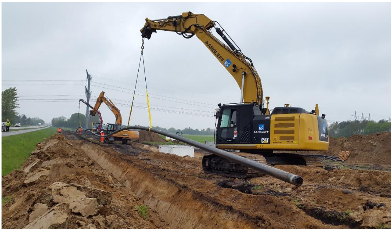
Figur 1-4 Nedlægning af gasrørledning i rørgrav.
