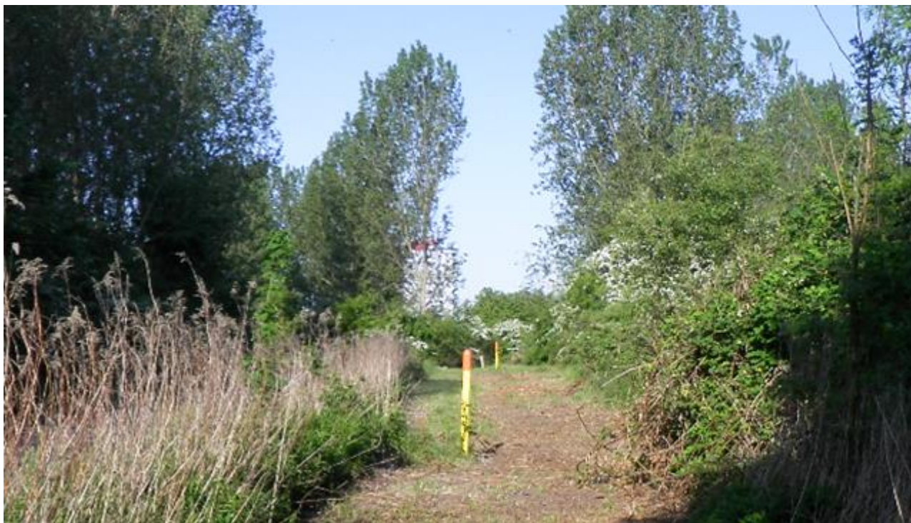
Figur 12-11 Viser et eksempel på et servitutbælte på fire meter i en skov og markeringspæle. Her må der ikke vokse træer. Billedet er taget kort efter at gasrørledningen er anlagt. Græs og urtevegetation vil med tiden vokse op inden for bæltet på 4 m.
