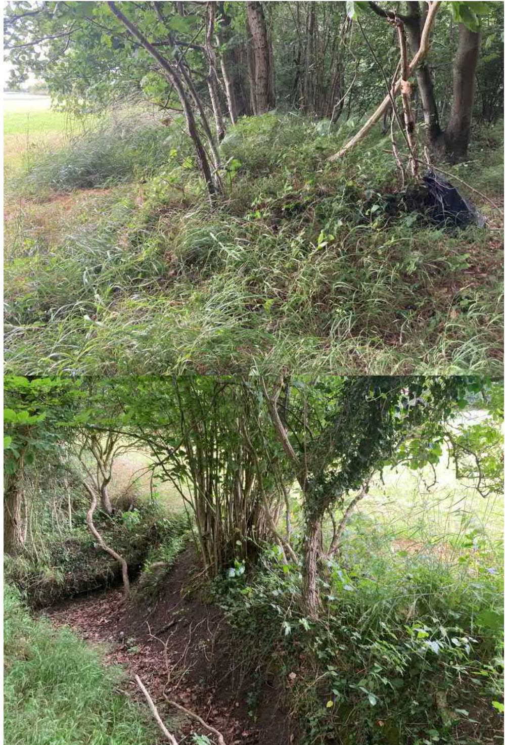
Figur 3-3 Diget set mod krydsningen i vestlig retning (øverst) og drængrøften der hvor krydsningen vil foregå, set i sydøstlig retning (nederst)
