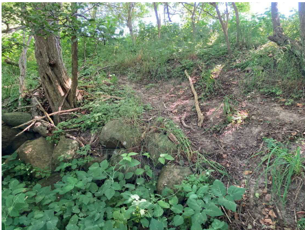
Figur 3-12 Set inde fra diget ved krydsningen i sydlig retning (øverst) og østlig retning (nederst)
