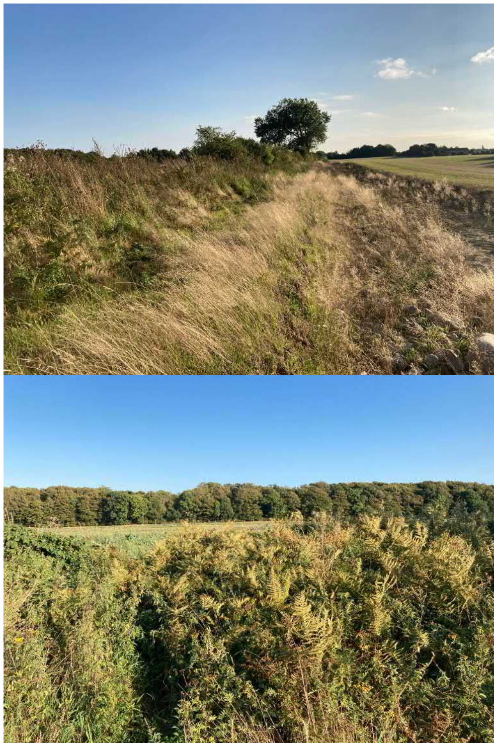
Figur 3-29 Set på kanten af diget og en af de gravede render i sydlig retning (øverst) samt midt på diget i østlig retning (nederst)
