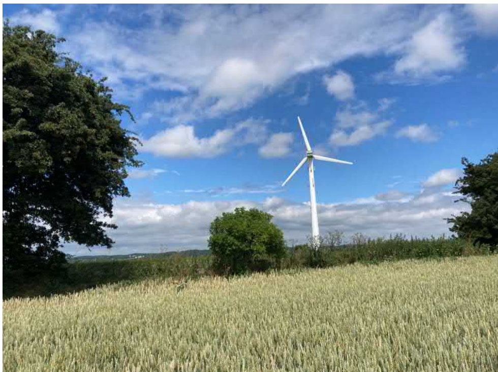
Figur 3-90 Set mod krydsningen i nordlig retning
