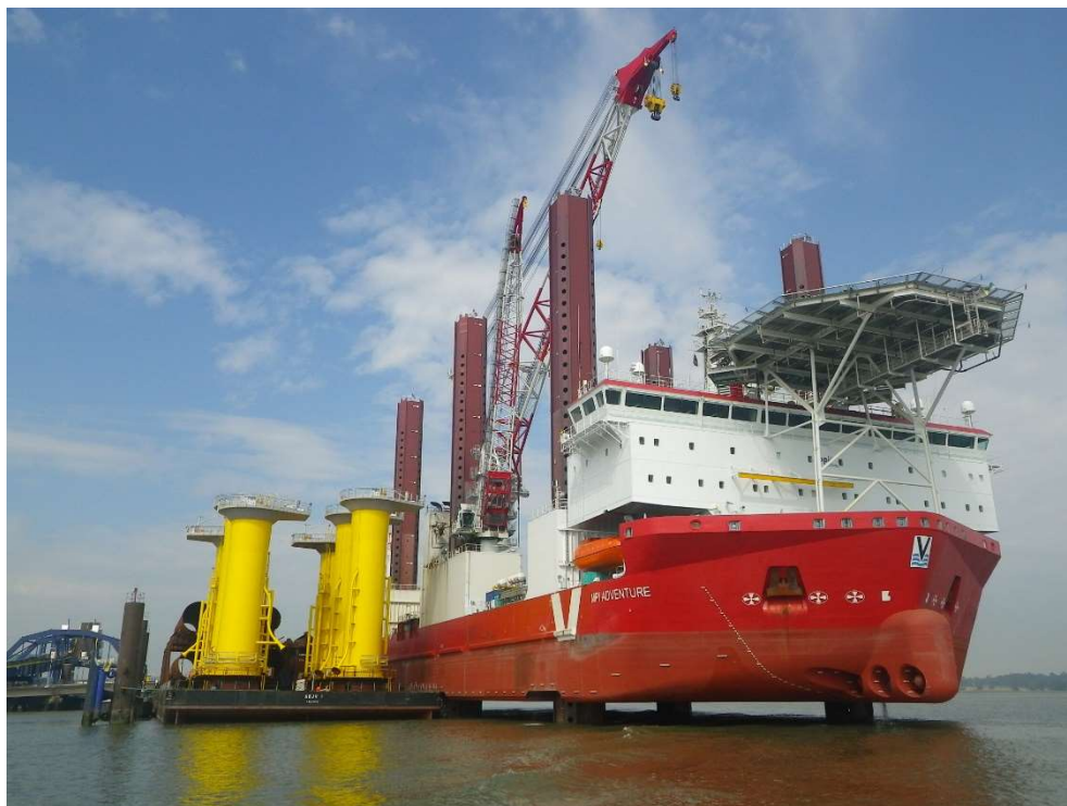
Figur 3-9 Installationsfartøj under positionering. Jack-up ben er ved at blive ned-sænket. Pram med monopæle og overgangsstykker ligger ved styrbord side.
