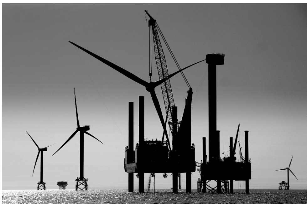
Figur 3-13 Installation af vindmølle ved hjælp af installationsfartøj med jack-up.
