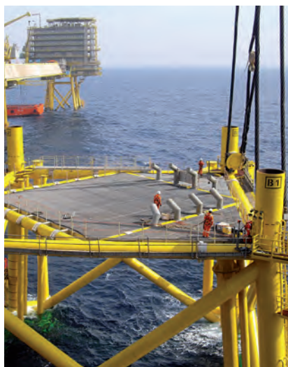
Installation af understel til Halfdan BD platform 2010.
