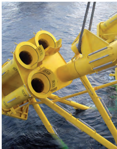
Installation af understel til Halfdan BD platform 2010.
