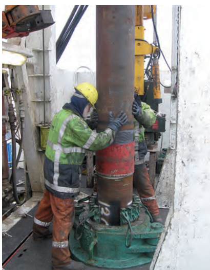
Foringsrør installeres i boring ved Sønderborg.
