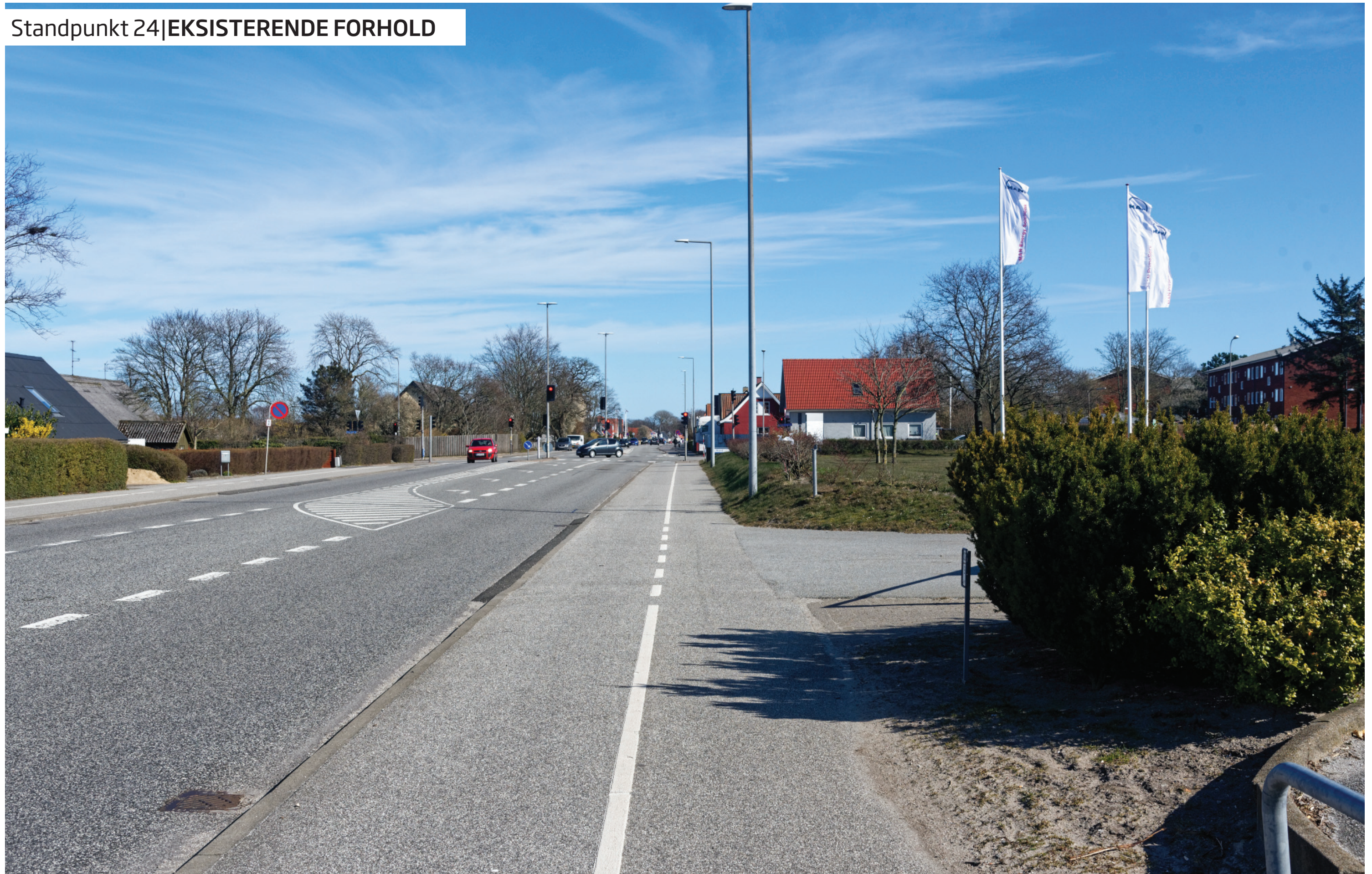
STANDPUNKT 24 - HJØRRINGVEJ/NIELS JUELS VEJ
