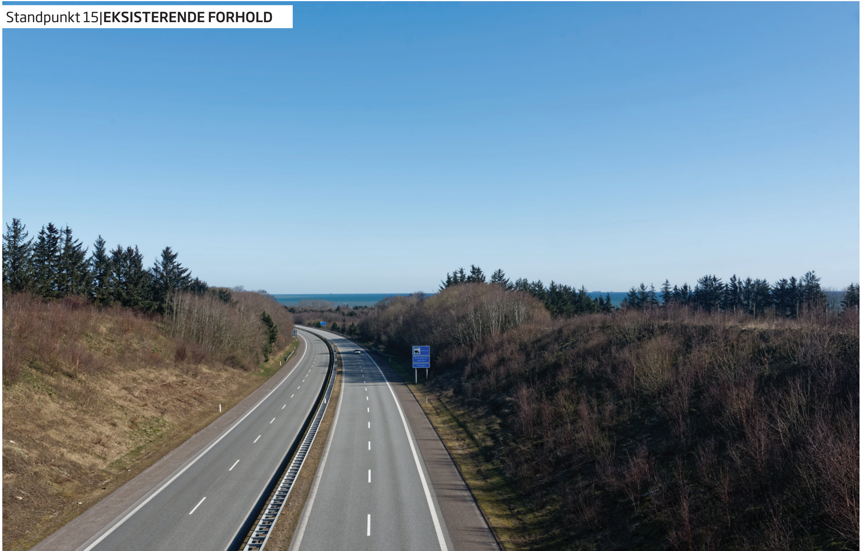
STANDPUNKT 15 - GADHOLTVEJ MOTORVEJSBRO
