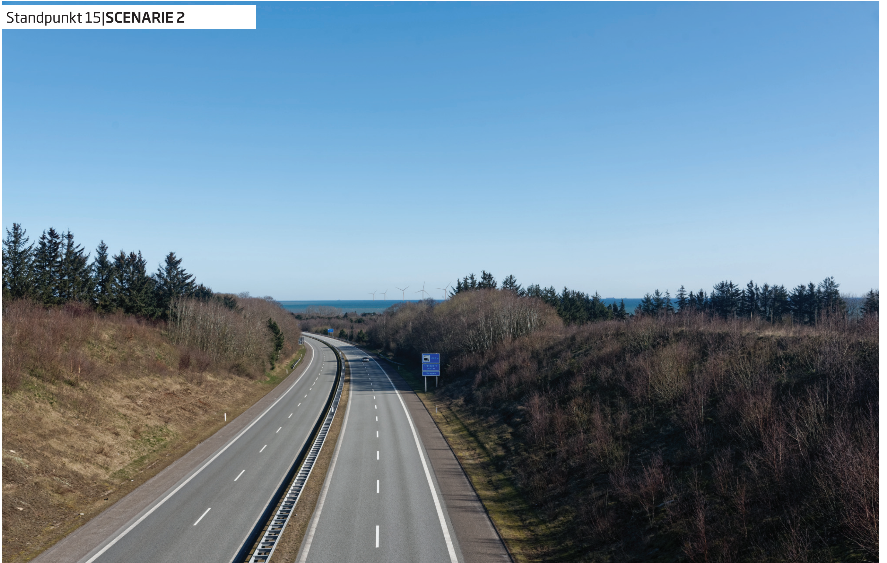
STANDPUNKT 15 - GADHOLTVEJ MOTORVEJSBRO AFSTAND TIL NÆRMESTE MØLLE : 11KM
