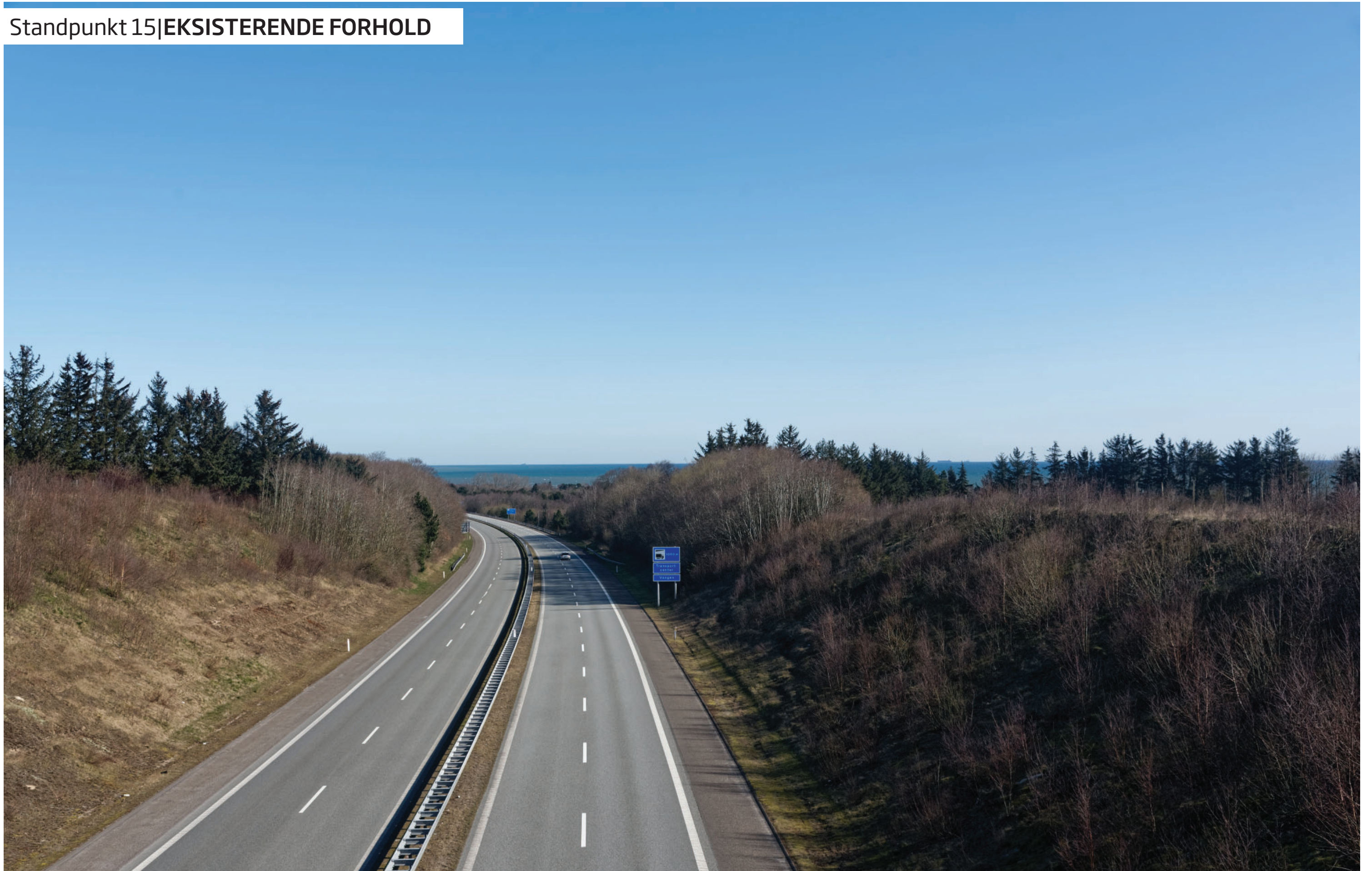
STANDPUNKT 15 - GADHOLTVEJ MOTORVEJSBRO
