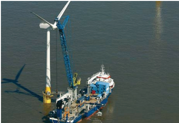
Figur 5.9 Installationsfartøj i gang med at montere møller.
