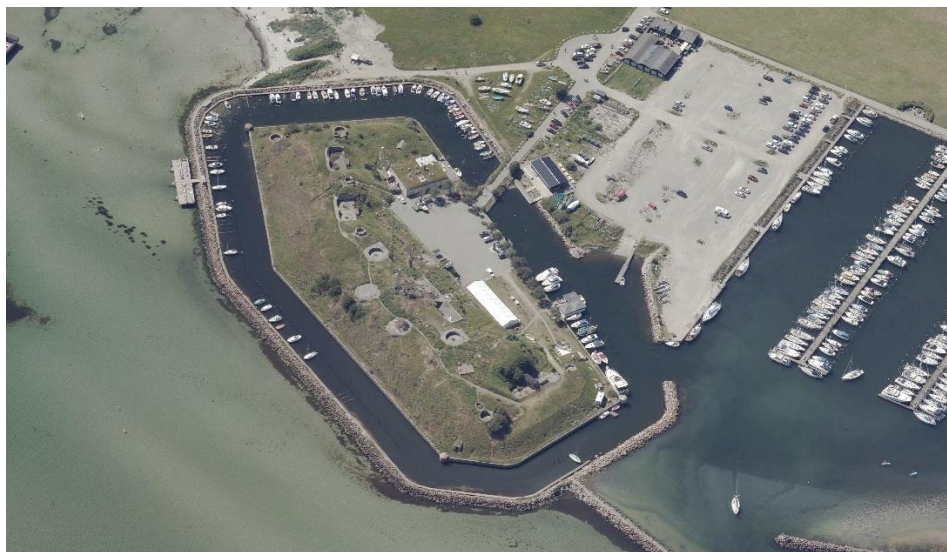
Figur 14.11: Skråfoto af Dragør Fort, juni 2019. Voldgraven anvendes i dag som lystbådehavn. (Foto: SDFE, Skråfoto)
