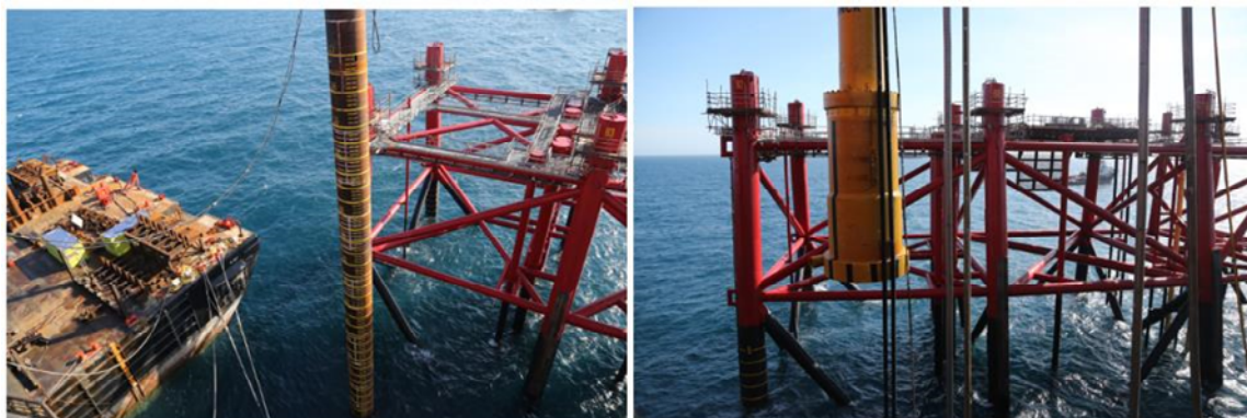
Figur 2-4 Pæl (venstre) og hammer til nedramning (højre)
