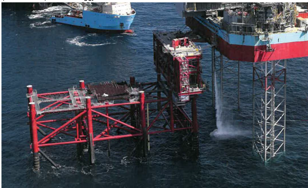
Figur 2-5 Brøndboring i Hejre feltet udført af Mærsk Resolve, sommer 2015
