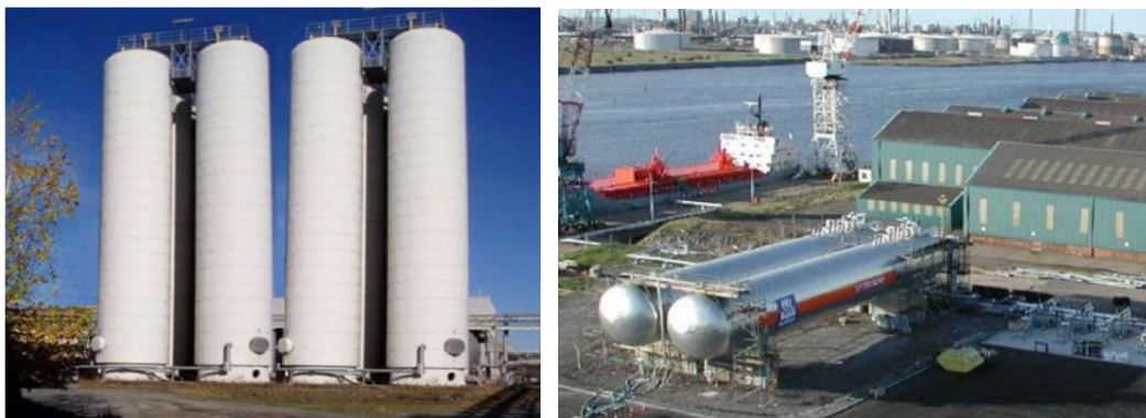
Figur 3-7 – Eksempler for mindre lagertanke til opbevaring af CO 2 . 16
