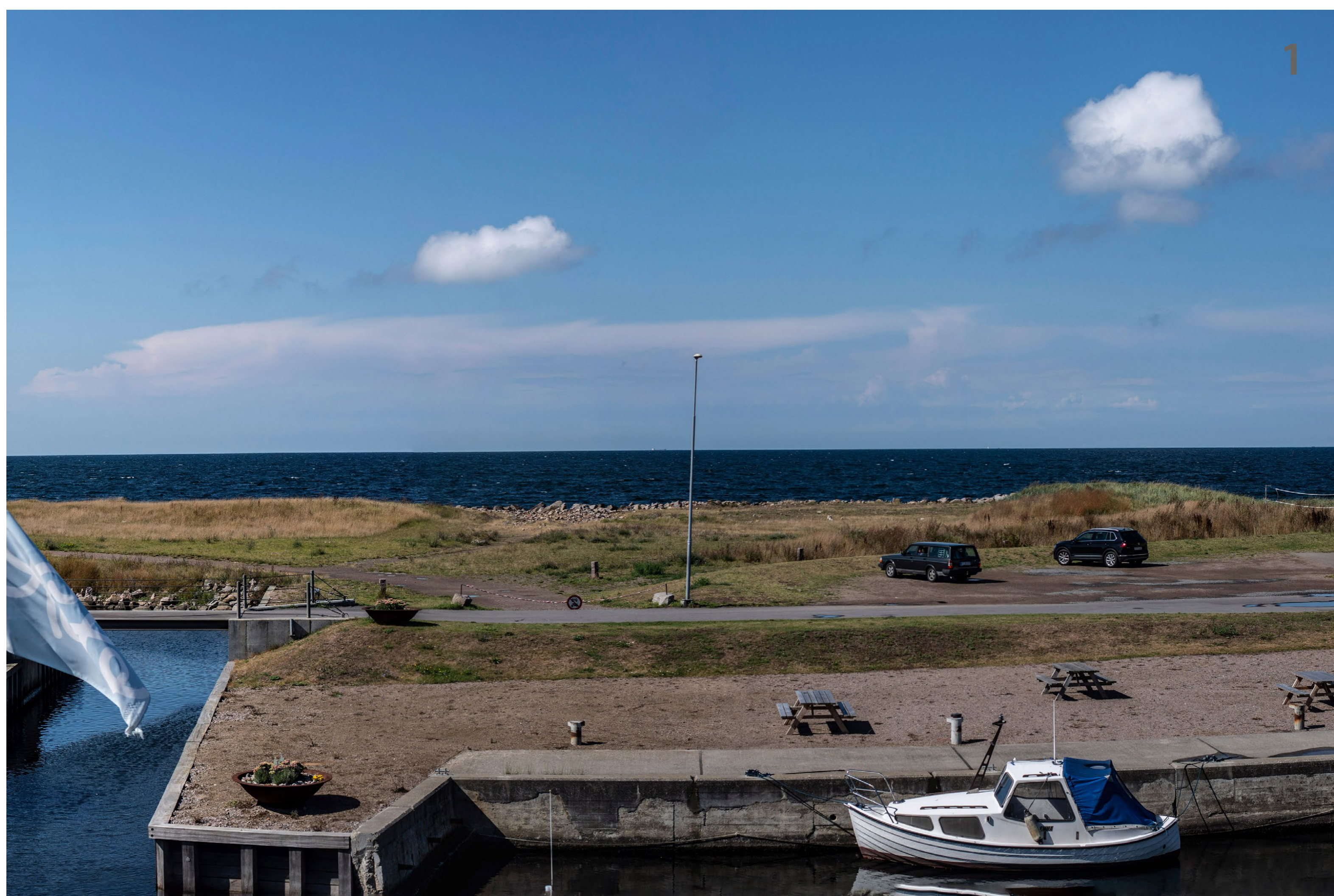
1: Hasle EKSISTERENDE FORHOLD - høje side af panorama
